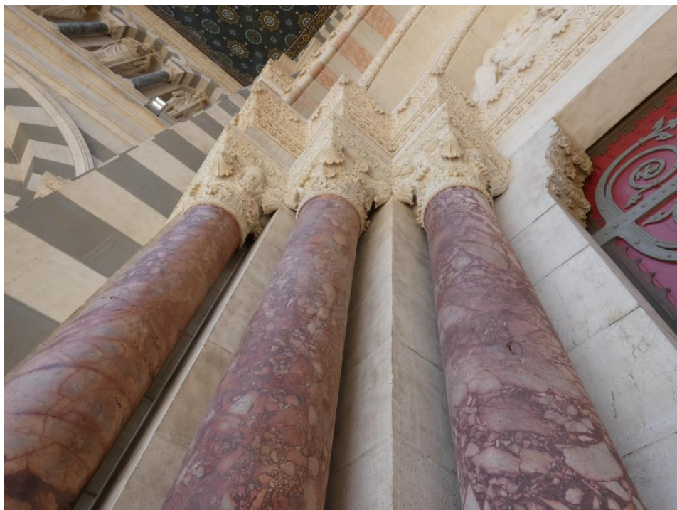
Espacements favorables entre les colonnes et les murs (face sud) © G. Kapfer
