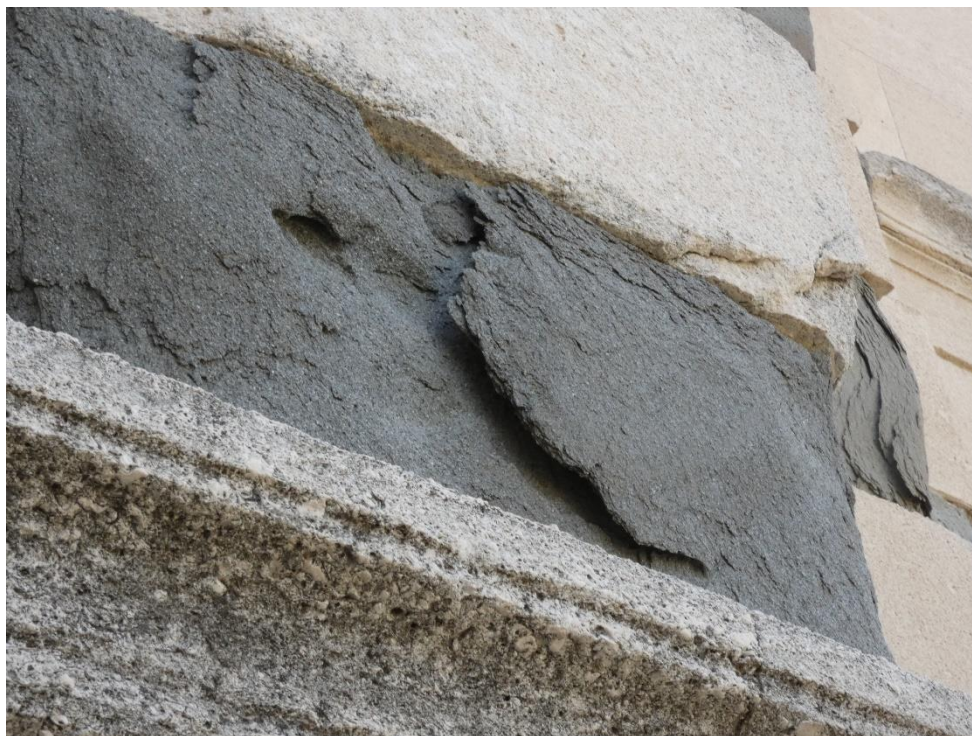
Exemple d'écaille favorable aux chiroptères formée par l'érosion de la roche (face est) © G. Kapfer
