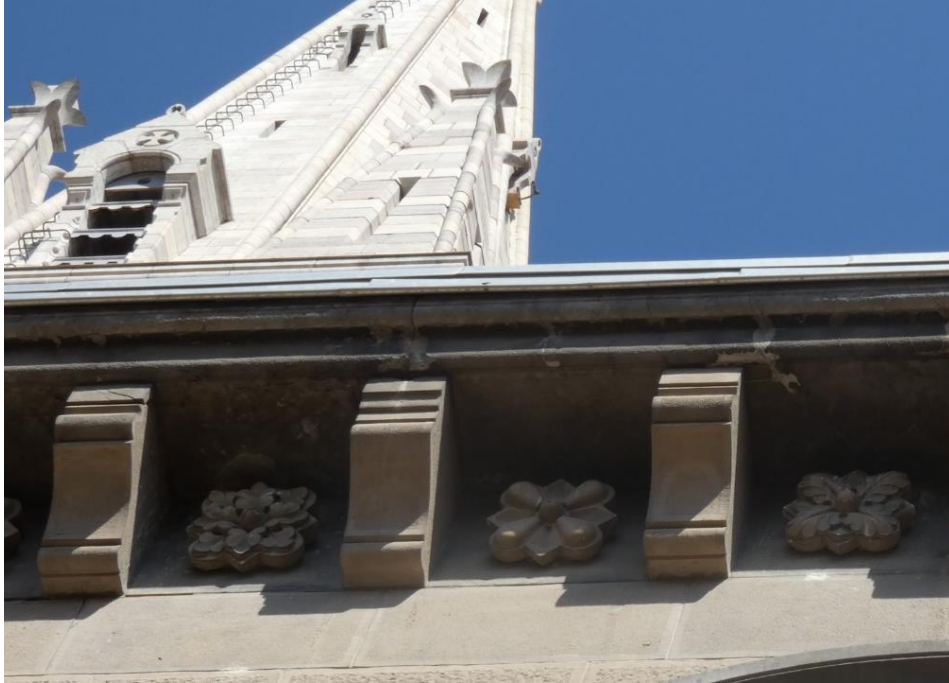
Au niveau de la couvertine
