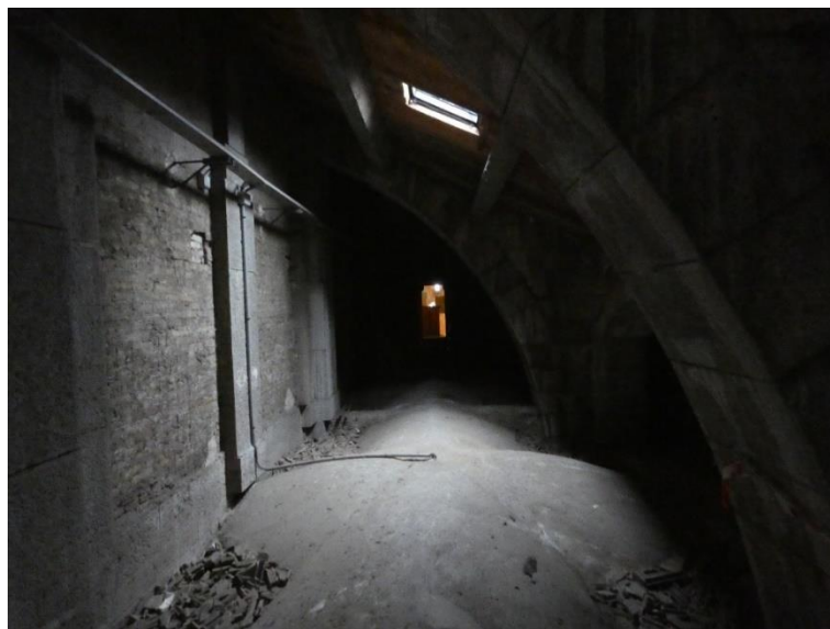
Charpente totalement rénovée
