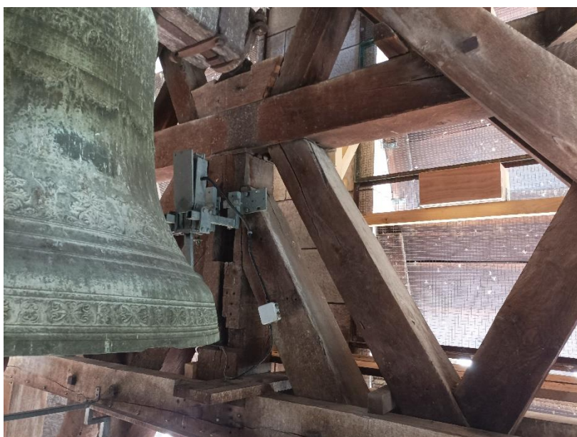
Figure 6 : exemple d'un nichoir à martinet en bois installé derrière les abat-sons sur la cathédrale Saint-Arnoux à Gap © C.Piccinin
