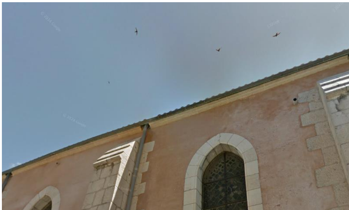
Drains dans la façade est, source Google Street View
