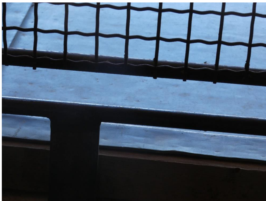
Espacement permettant le passage de chauves-souris, clocher © G. Kapfer
