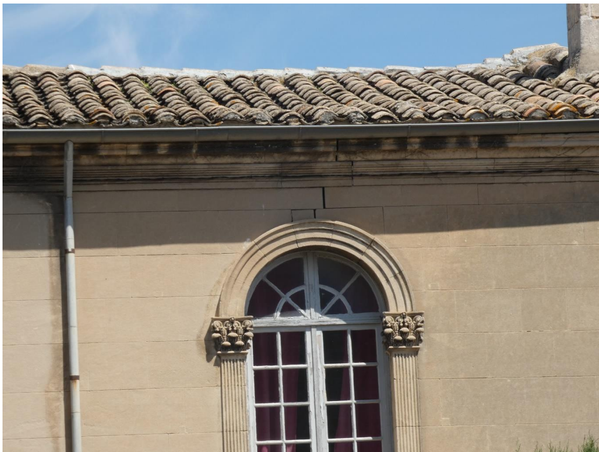
Disjointements entre les pierres et toiture utilisable - face sud © G. Kapfer
