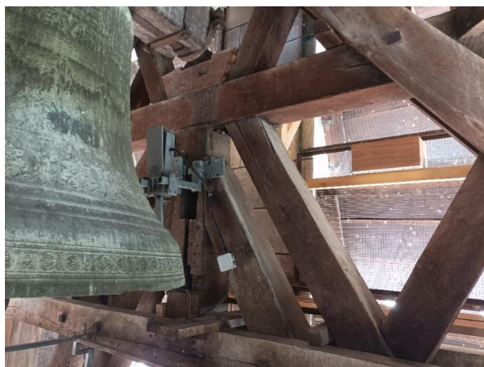
Figure 5 : exemple d'un nichoir à martinet en bois installé derrière les abat-sons sur la cathédrale Saint-Arnoux à Gap © C.Piccinin
