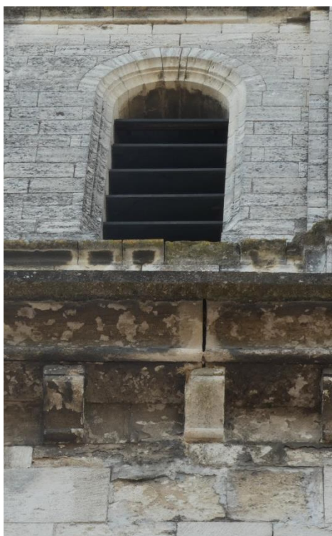
Exemple de disjointement © G. Kapfer
