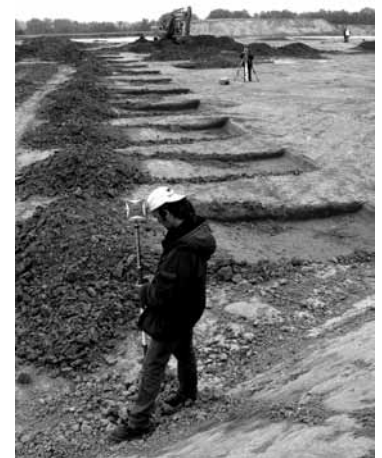
SAINT-VIGOR-d'YMONVILLE, Les Sapinettes - La Mare des Mares : Fouille mécanique d'un fossé
