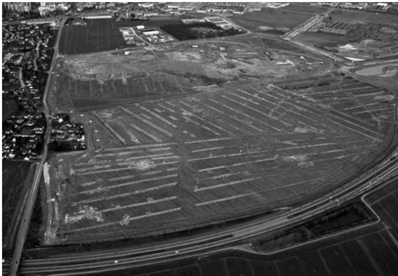
Guichainville « le Long Buisson », vue aérienne du chantier
