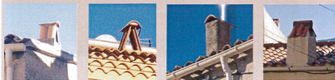
Exemples de souches de cheminée couvertes de tuiles
