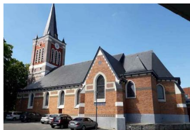
ville de Villeneuve d'Ascq
