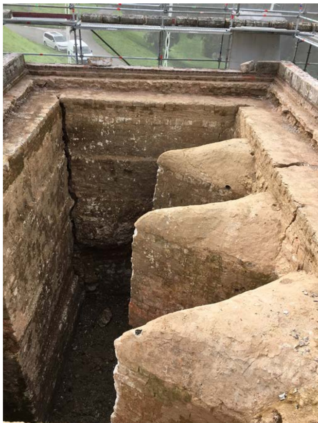
Eu, Bastion du château : vue vers l'ouest de l'intérieur du bastion vidé, avec les trois contreforts. Le décrochement de l'angle SO de l'ouvrage est bien visible avec la fissure (S. Togni-Devillers).
