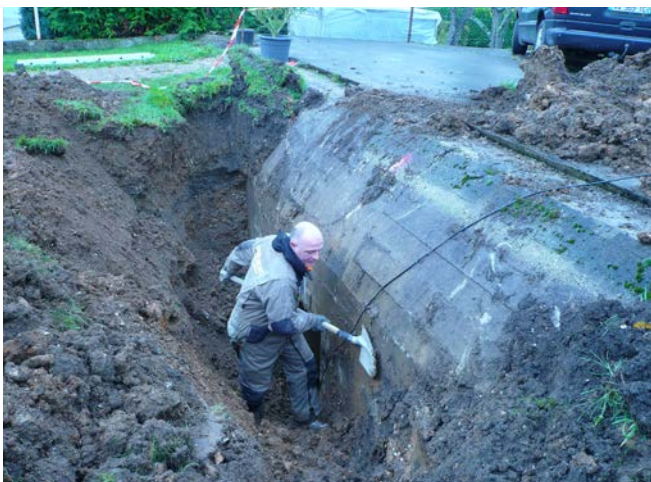
Dieppe, Neuville-lès-Dieppe, Cité Castors, fig. 1 : l'avant de l'ouvrage en cours de dégagement (S. Mathieu).
