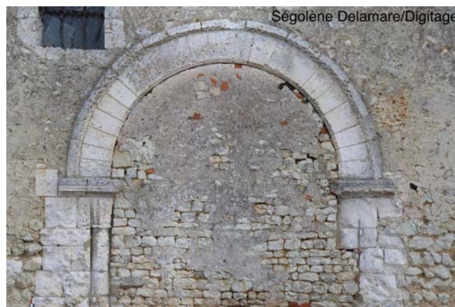
Hodeng-Hodenger, église Notre-Dame : portail sud de la nef (S. Delamare/Digitage).
