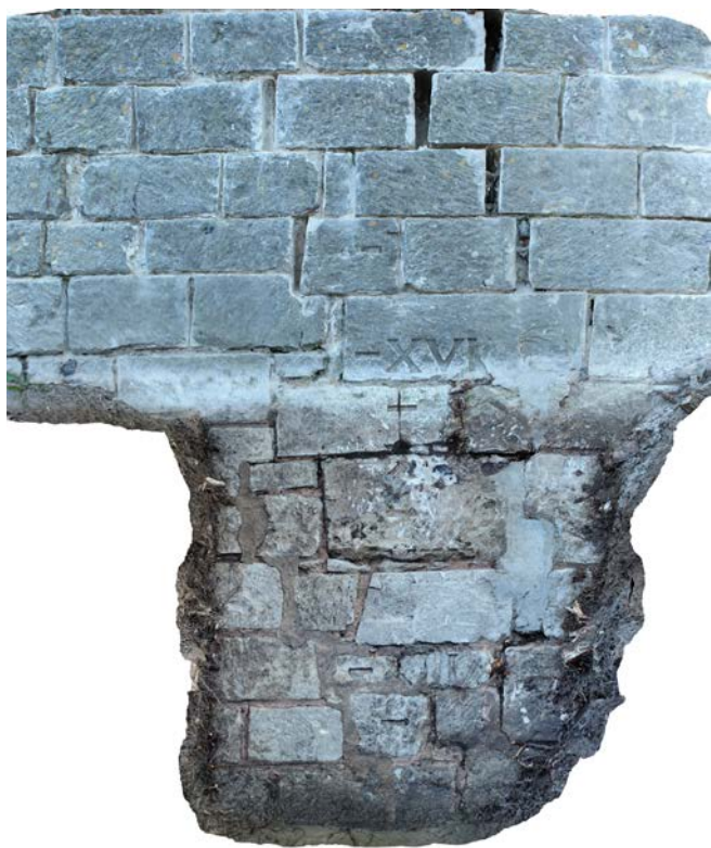
Vernon, Quai de Seine, Les Tourelles, fig. 2 : Photogrammétrie du mur de quai faisant partie de l'enceinte sud des Tourelles (N. Wasylyszyn).
