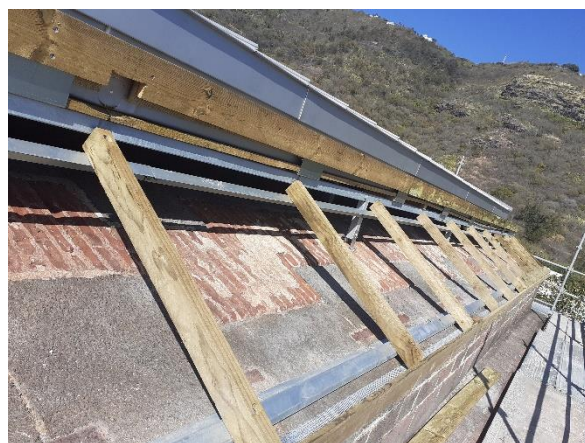
Durant les travaux
