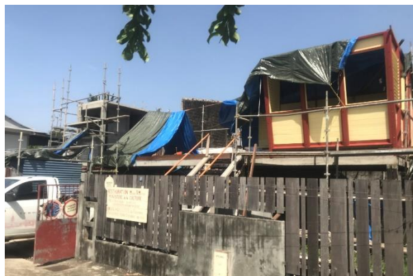
Durant les travaux
