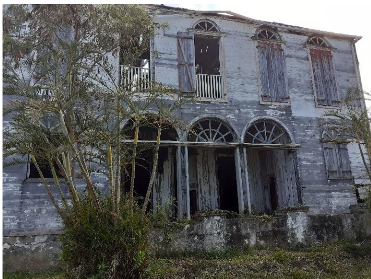
La maison avant intervention
