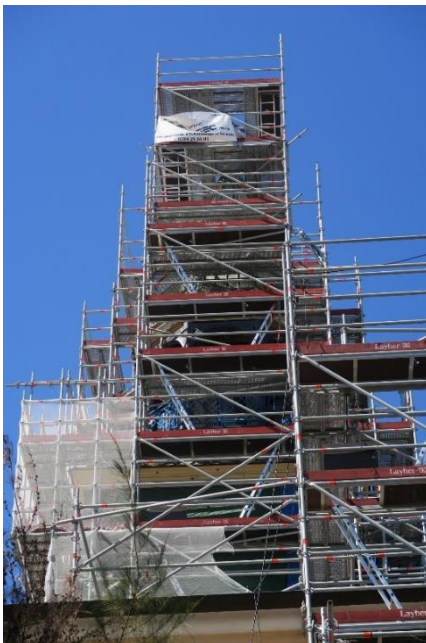
Durant les travaux
