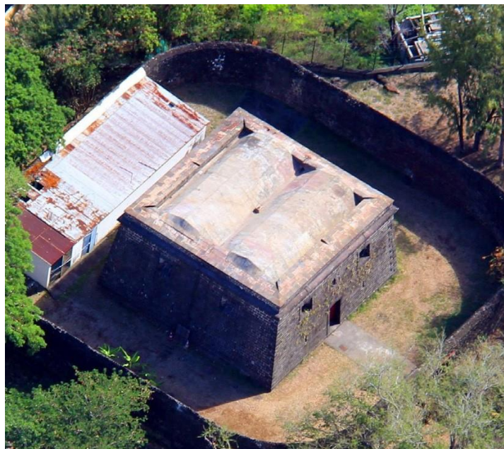
Avant restauration de la couverture
