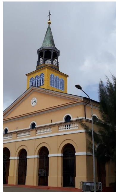
La cathédrale après restauration
