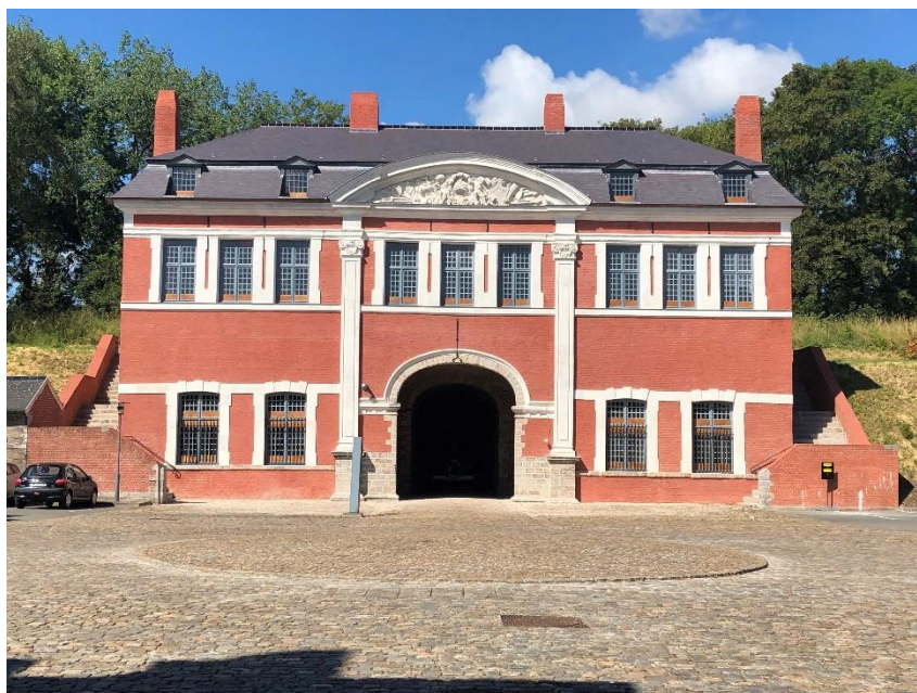
La porte Dauphine après sa restauration. Le chantier s'est achevé en mai 2020.
