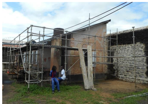
Durant les travaux
