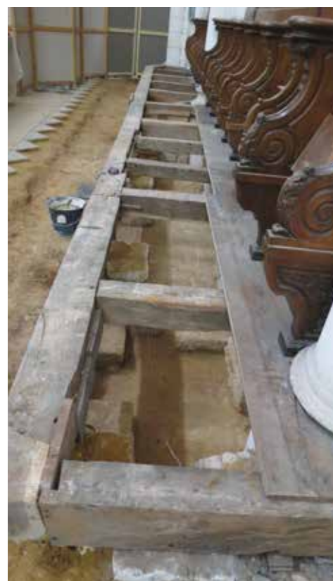
Côté nord du chœur : le premier rang des stalles a été déposé pour avoir accès aux substructures. On observe leur aménagement sommaire : de simples cales en briques très irrégulières viennent s'intercaler entre les piles en maçonnerie et le lambourrage, cl. DRAC, C. Mathurin
