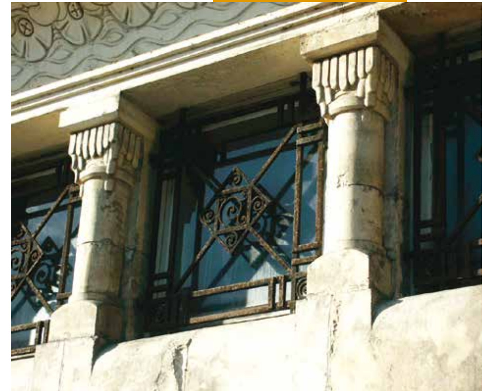
Baies éclairant les cabines, cl. DRAC, P. Gros
