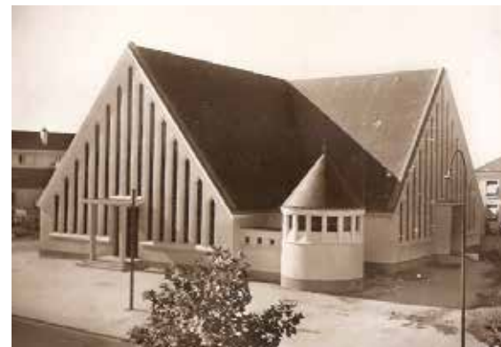
Église Saint-Gohard, entrée principale et vue sur le baptistère, cl. Archives départementales de Loire-Atlantique
