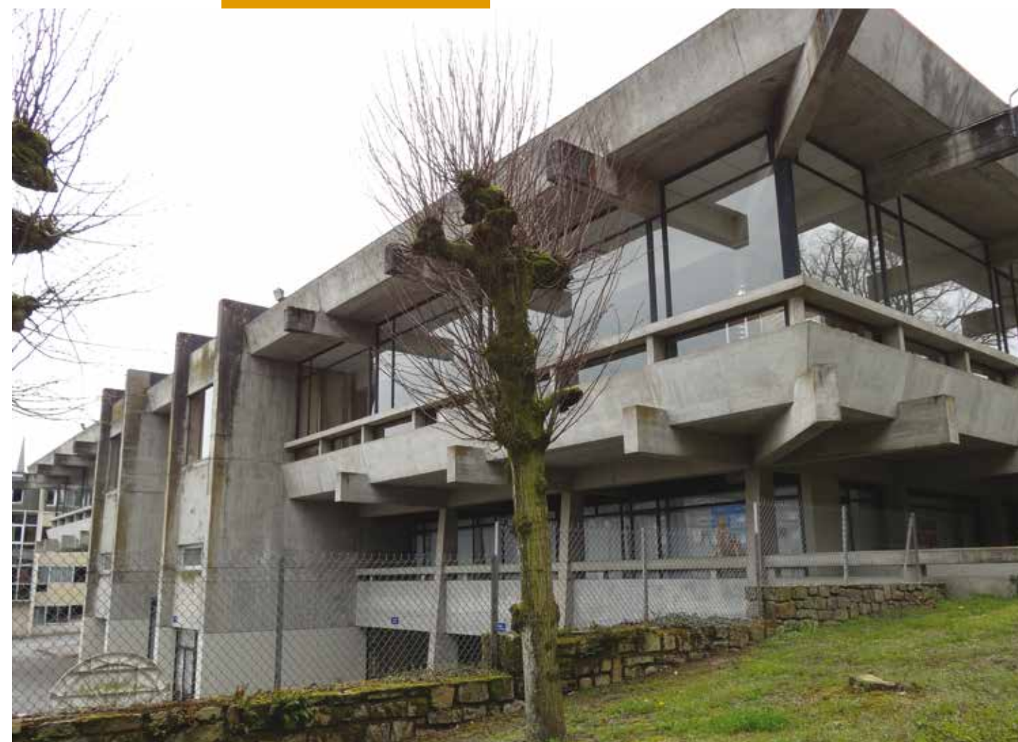
Vue extérieure, cl. DRAC, P. Gros
