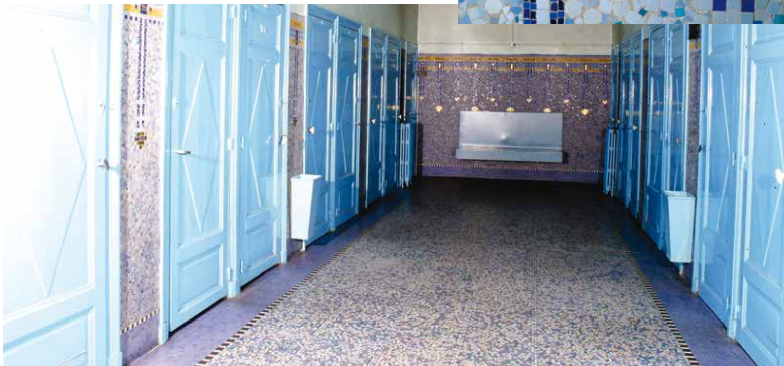
Couloir des douches, cl. F. Lasa © Région Pays de la Loire - Inventaire général
