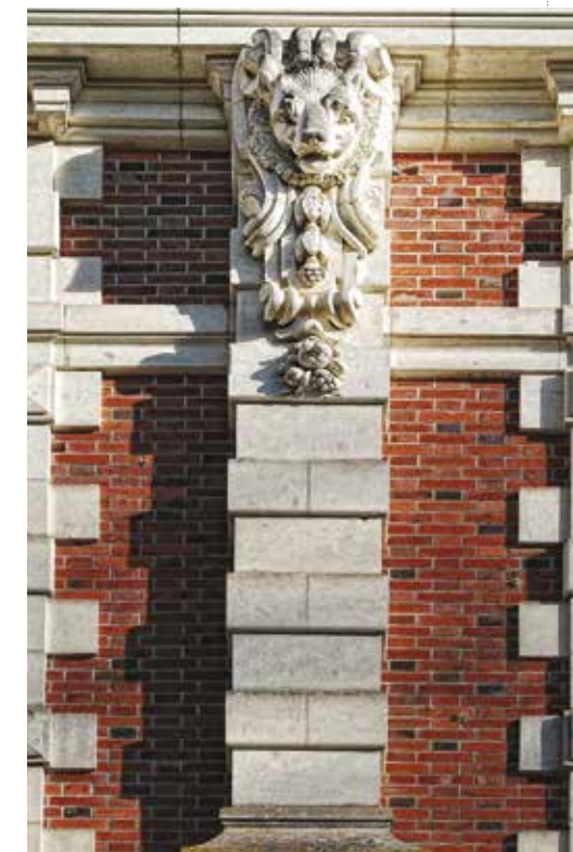
Louve des ducs de Plaisance, détail de la façade, cl. D. Dautel
