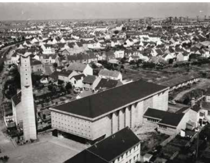
Église Sainte-Anne, vue aérienne, cl. Archives départementales de Loire-Atlantique
