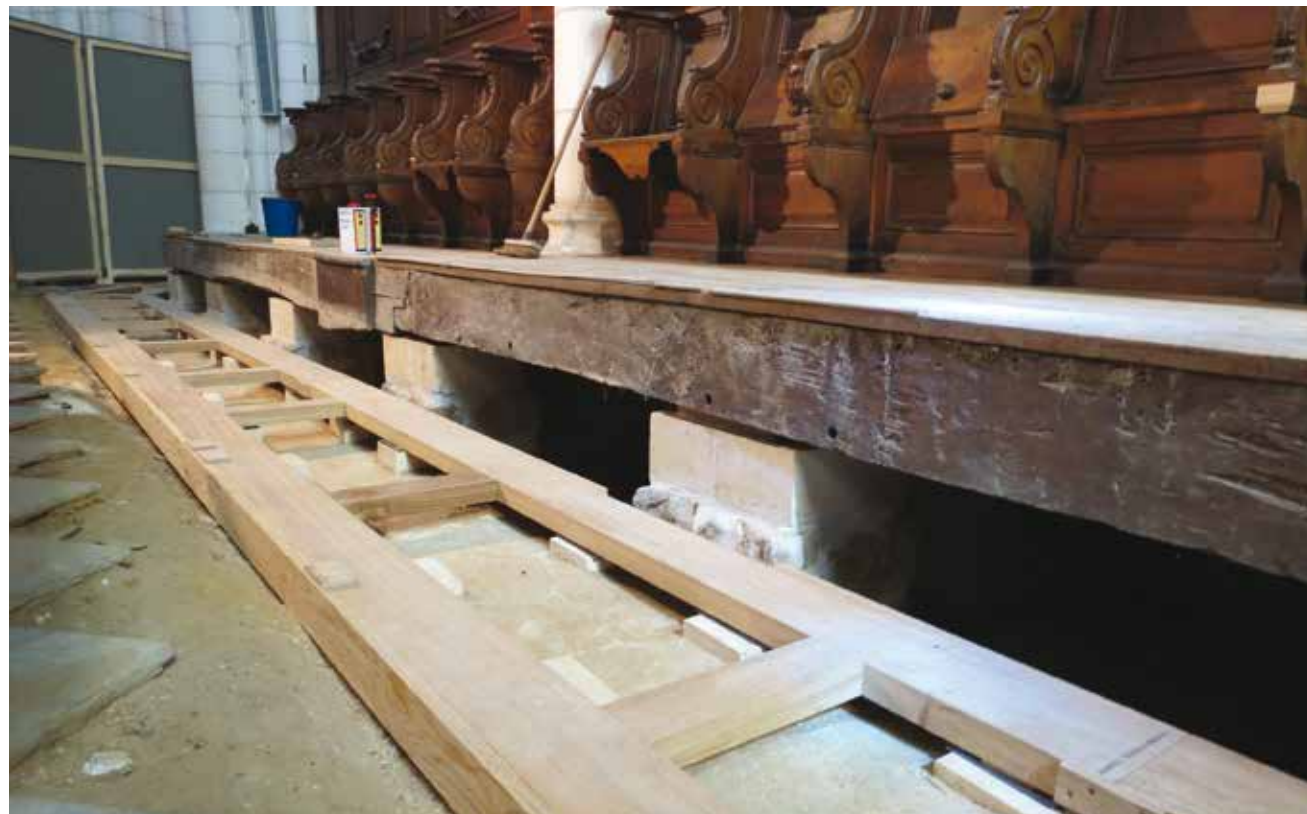
Côté nord du chœur : les substructures sont entièrement reprises et notamment le lambourrage, ici visible. Les lames de parquet, changées quand cela était nécessaire, vont être ainsi posées sur une structure saine, permettant la circulation de l'air et donc une meilleure conservation des bois, cl. DRAC, C. Mathurin
