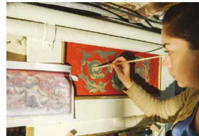
La restauratrice de décors peints recréant les panneaux en grisaille manquants d'après le modèle original, cl. Arthéma Restauration
