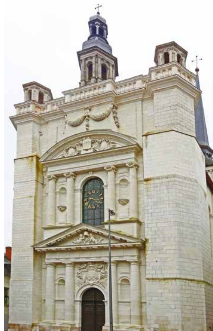
Façade occidentale après restauration, cl. DRAC, C. Mathurin
