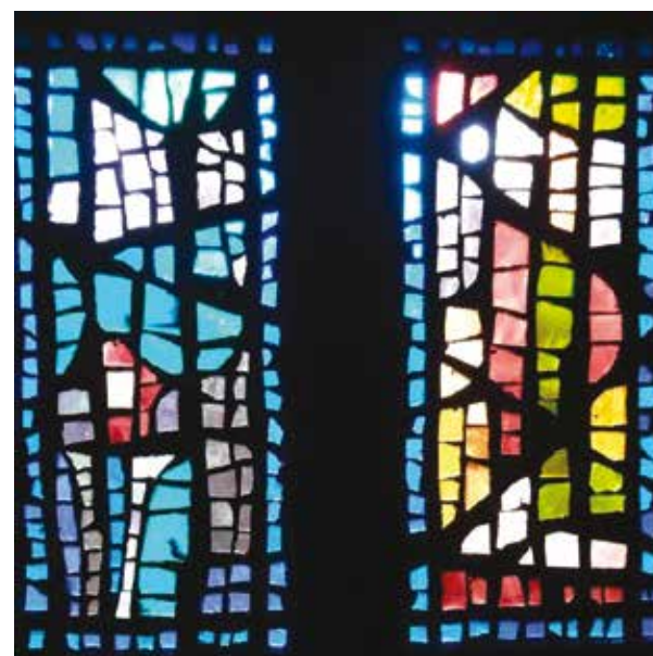
Vitrail du baptistère, en dalles éclatées à réseau de ciment armé, cl. DRAC, P. Gros
