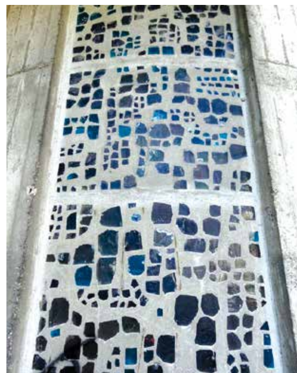
Vitrail du baptistère, en dalles éclatées à réseau de ciment armé, cl. DRAC, P. Gros
