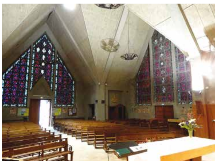
Ossature béton, arcs angulaires brisés, verrières sud et ouest, cl. DRAC, P. Gros
