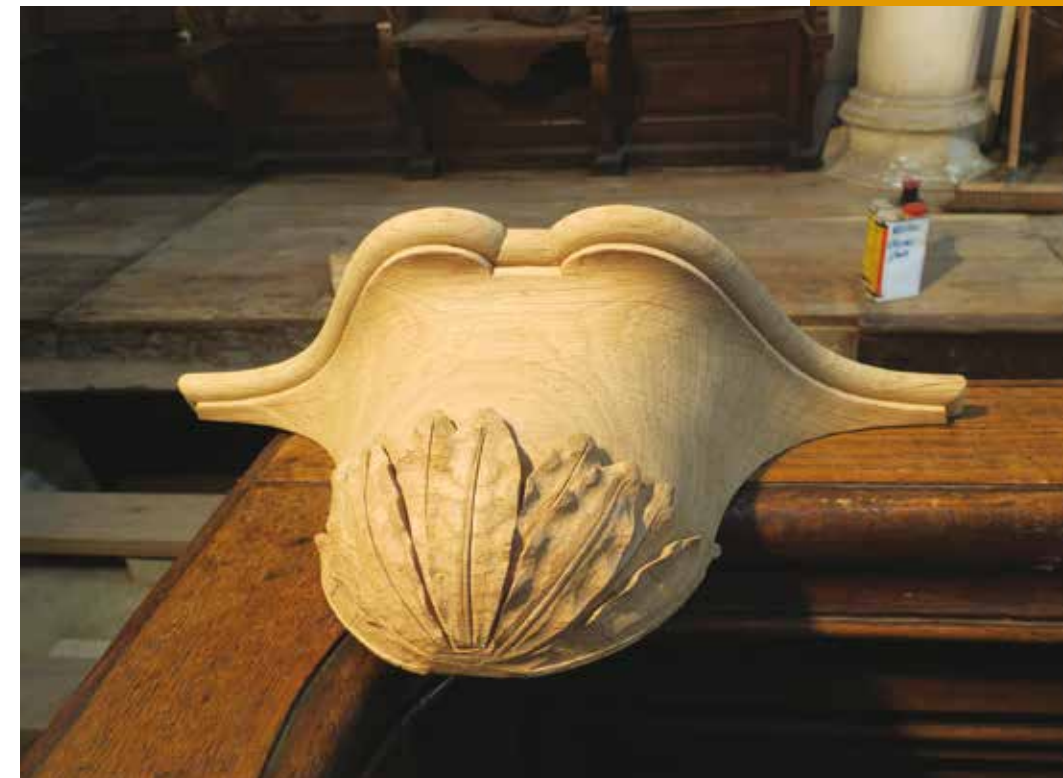
Les misericordes manquantes sont resculptées suivant les modèles présents : à feuilles d'acanthos pour les stalles hautes, de laurier pour le rang du bas. Elles sont dans un second temps mises en teinte pour s'harmoniser avec les bois anciens, cl. DRAC, C. Mathurin
