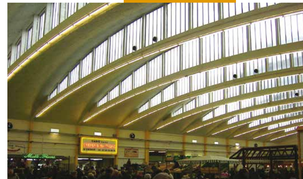
Intérieur du marché couvert, sheds conoïdes, face intérieure nord, cl. DRAC, P. Gros
