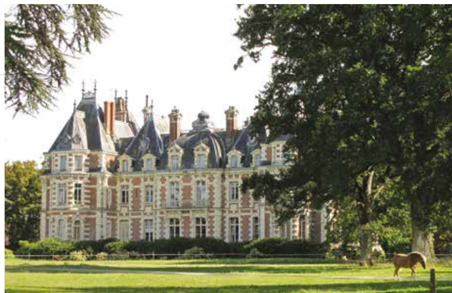
Vue sur la façade extérieure depuis l'étang, cl. DRAC, S. Peron
