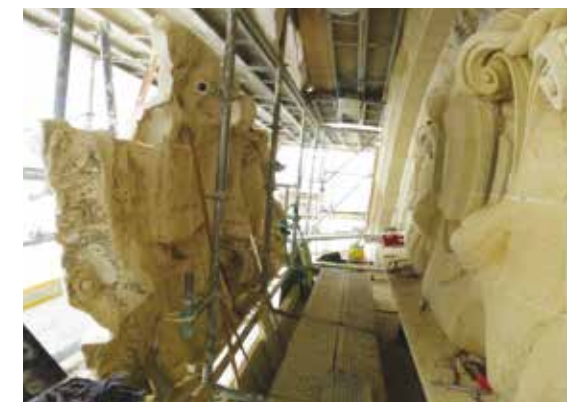
Restitution des sculptures du tympan supérieur : le moulage en plâtre en vis-à-vis, cl. DRAC, C. Mathurin
