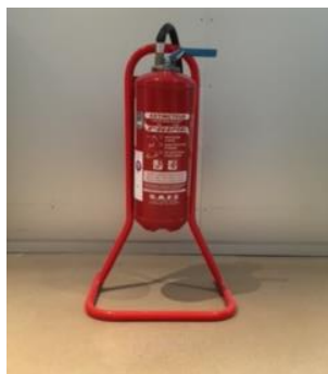
Extincteur à eau sur socle
