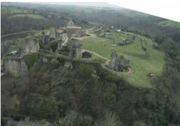
Fig. 105 - Vue du château depuis l'est
