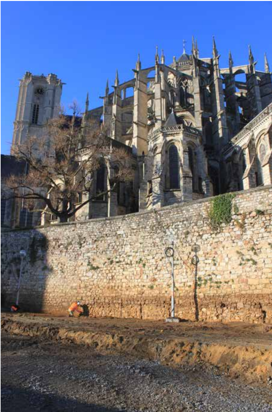
Fig. 138 - Courtine médiévale, une partie de la fondation en cours de fouille
