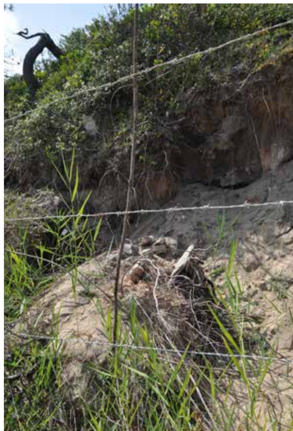
Fig. 73 - État du site avant sondage archéologique
