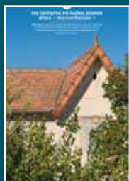
16 les toitures en tuiles plates
