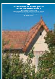
16 les toitures en tuiles plates dites marseillaise
