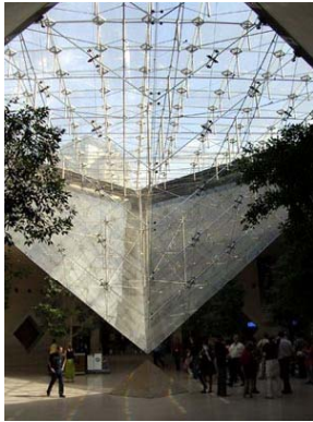
« La Pyramide Inversée », éclairant l'espace sous la Cour (ou Place) du Carrousel, composée de 84 losanges et 28 triangles.
