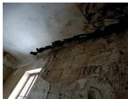
Tour Nord deuxième Étage - infiltration, pourrissement des solives du plafond et décollement des plâtres du mur
