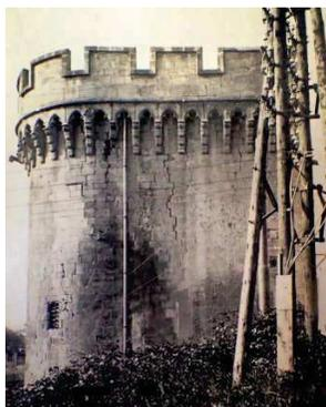
Photographie ancienne de la Tour Nord en 1920 - fissuration du parement
