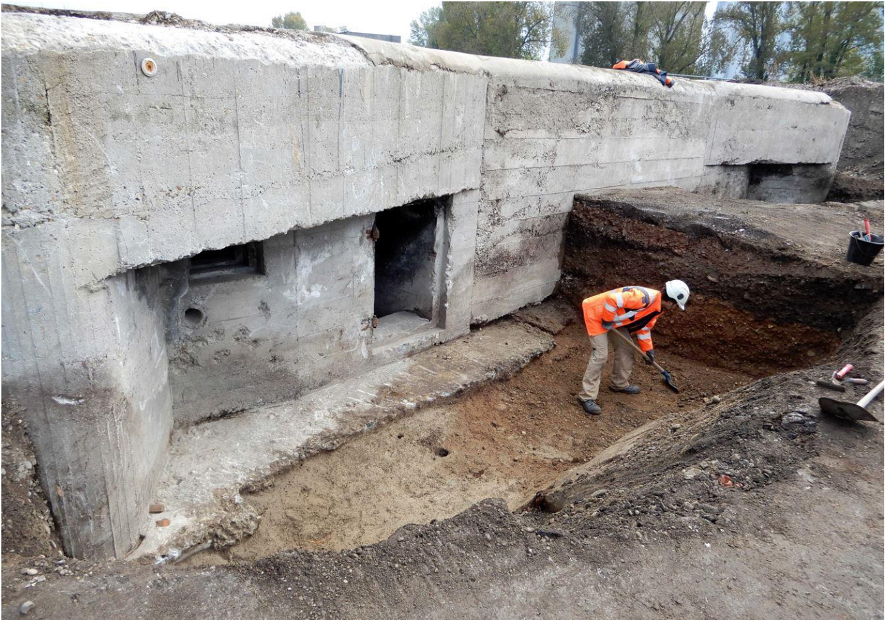
Fig. 2. Vue de la casemate en cours de fouille.
