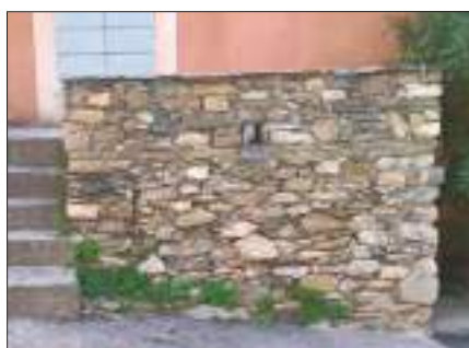
Garde-corps traditionnel en pierres délimitant un perron
