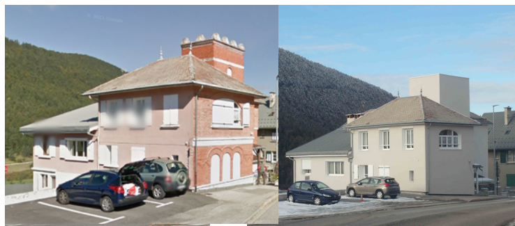
Exemple d'Isolation Thermique par l'Extérieure (ITE) : perte totale de la qualité architecturale du bâtiment : les briques rouges et les baies du rdc (à gauche) ont disparu au profit d'une façade simple. La tour laisse place à un cube blanc au dessus de la toiture.
