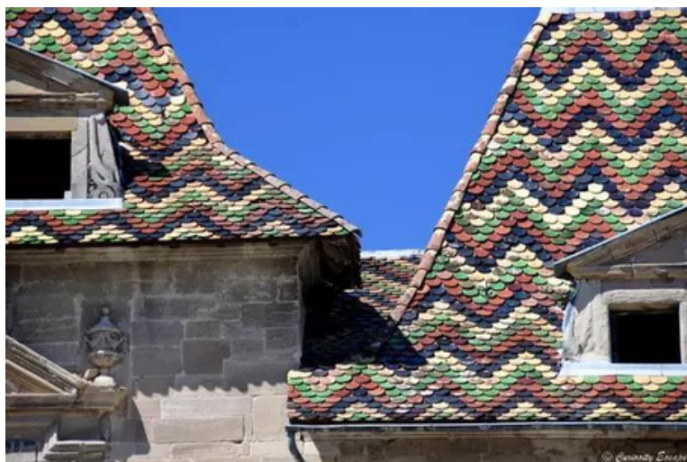
Toiture de la porterie de l'abbaye- Saint Antoine l'Abbaye, Isère
