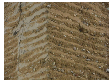
Photo du service : mur en pisé
