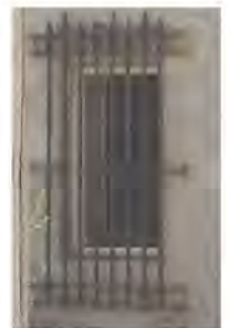
Exemple de grille de défense sur une maison de maître
