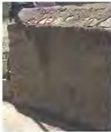
Exemple de mur travaillé en pointe
