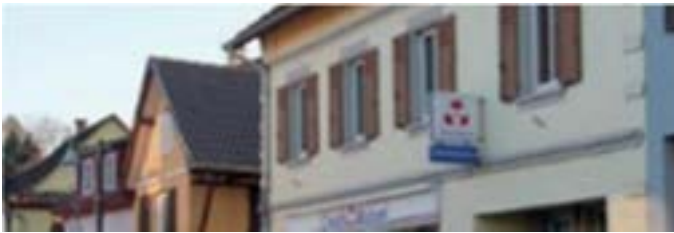
Hangenbieten : un caisson placé très haut
