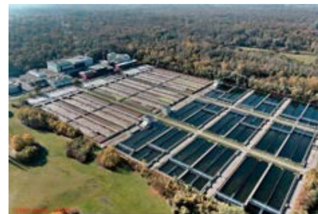
Station d'épuration de Strasbourg – La Wantzenau
