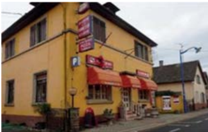
Eschau : sur cet immeuble, trop d'enseignes d'une faible qualité (caisson en plastique). Le RLPi en imposant des règles de quantité et de qualité, améliorera l'image générale de l'établissement et de la rue.
