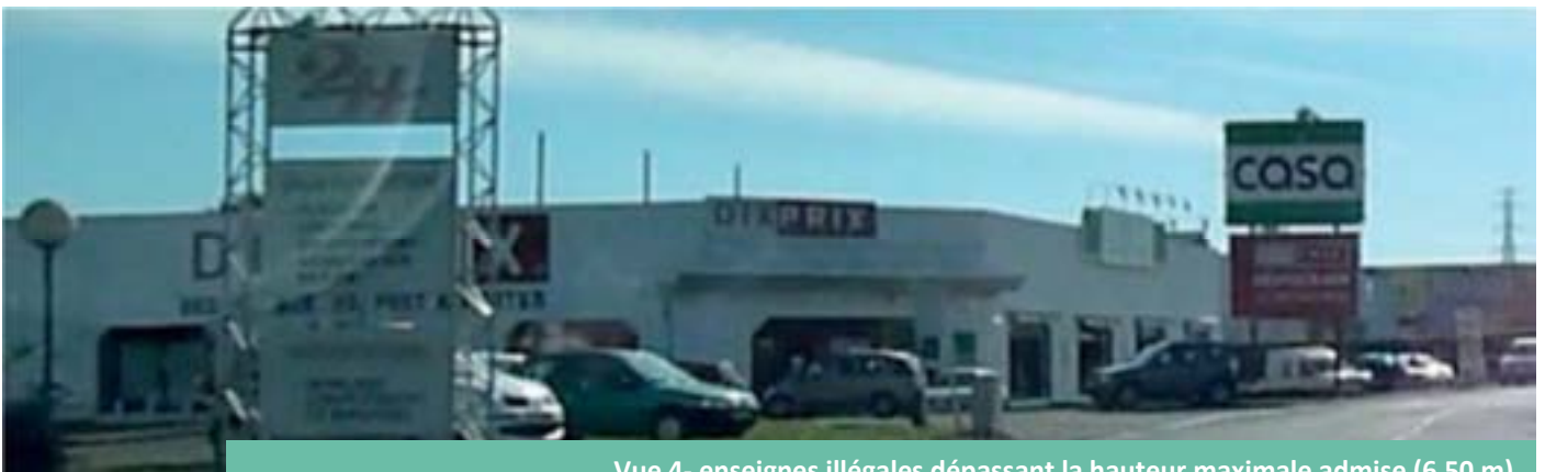
Vue 4- enseignes illégales dépassant la hauteur maximale admise (6,50 m)
