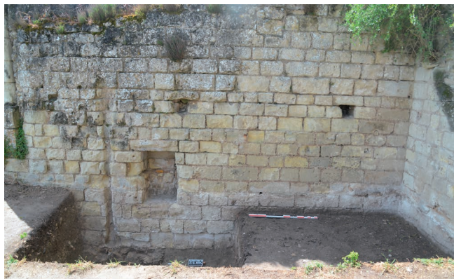
Fig. 2 : Tours (Indre-et-Loire) Marmoutier : vue depuis l'est des maçonneries modernes situées à l'extrémité occidentale de la deuxième terrasse, supposées correspondre à l'ancienne maison du prieur des Sept-Dormants. (Élisabeth Lorans, Université de Tours)
