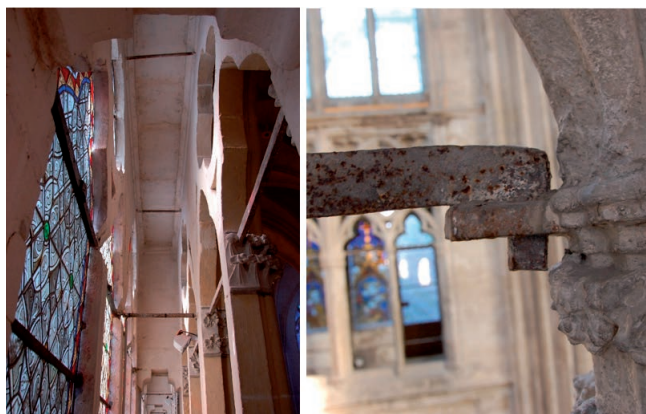
Fig. 1 : Tours (Indre-et-Loire) cathédrale Saint-Gatien : vue générale des renforts en métal du XIII e s., couloir du triforium du chœur, 3e travée occidentale côté Sud, vue depuis l'est (à gauche) ; assemblage crochet-œil d'un tirant en métal du XIV e s., arcature du triforium de la nef, 1ère travée orientale côté Sud, vue depuis le Sud (à droite). (Sarah Prodhon, UMR CITERES-LAT)
