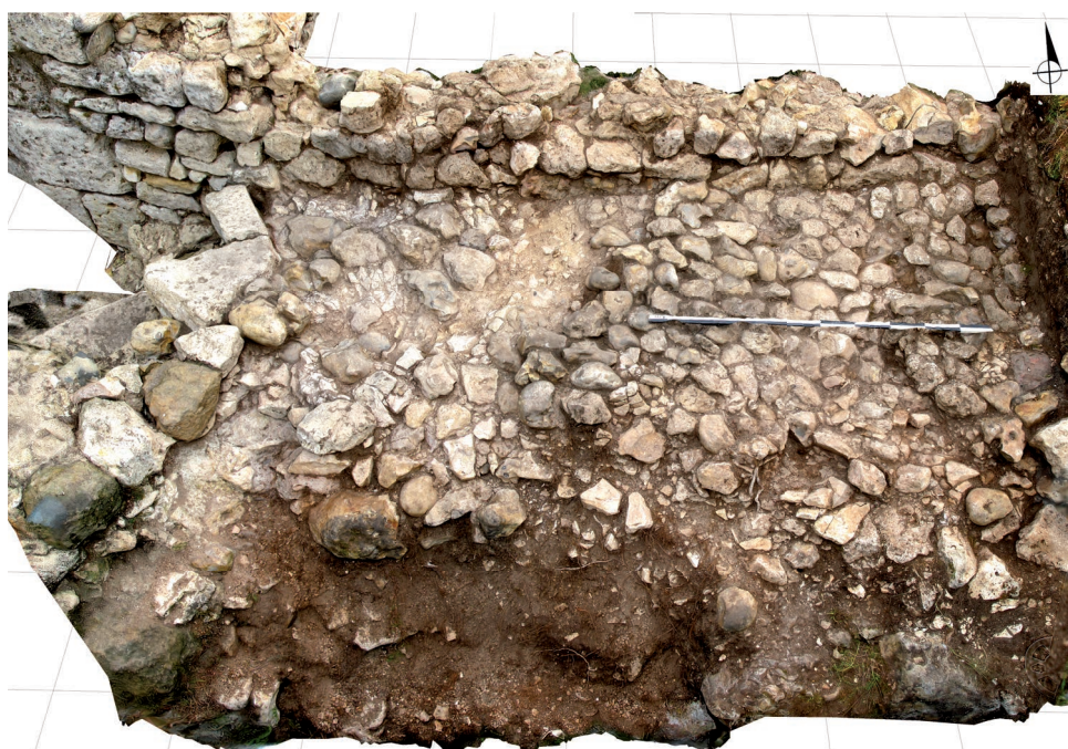
Fig. 3 Dordives (Loiret) château de Metz-le-Maréchal : vestiges du chemin de ronde sur la cortine C5, à la sortie de la tour T4. (Michel Piechaczyk, ADM)
