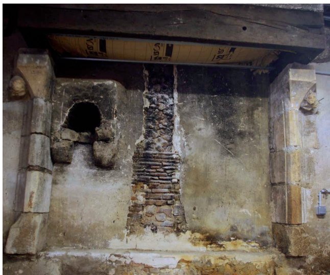
Fig. 3 : Beaulieu-sur-Loire (Loiret) 10 place de l'Église : la cheminée du XVe s. (Estelle Delmont, Inrap)
