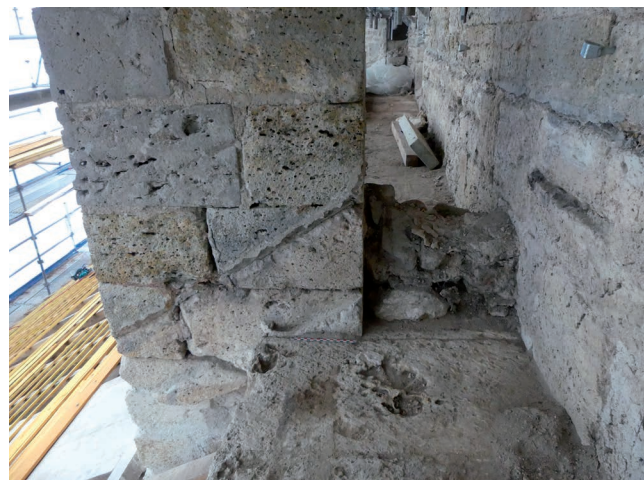
Boiscommun (Loiret) église Notre-Dame : vue de détail sur la coursive sud le long du mur-gouttereau de la nef avec au sol vestige d'un dispositif d'évacuation d'eau. (Florence Tane, Inrap)
