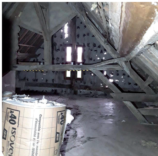
Fig. 2 : Beaulieu-sur-Loire (Loiret) 10 place de l'Église : la charpente de la mairie. (Estelle Delmont, Inrap)
