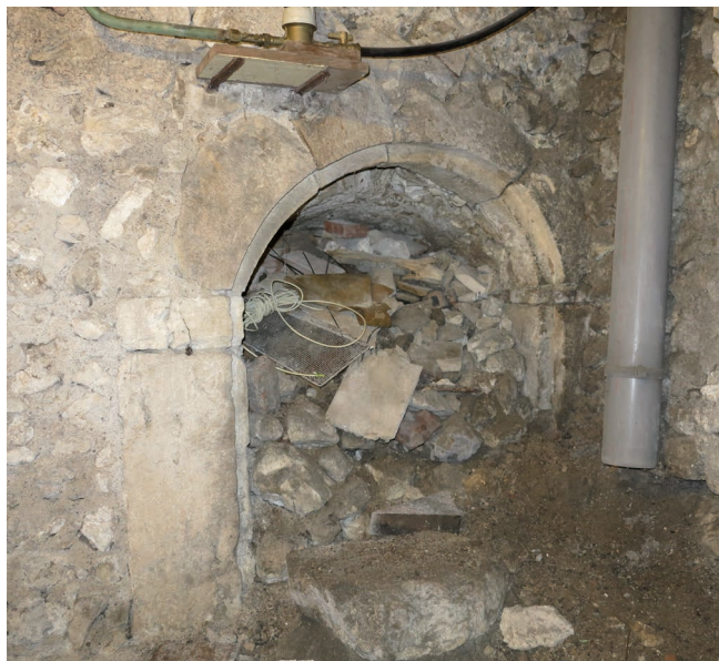
Fig. 2 : Orléans (Loiret) caves du centre-ville : quartier sud de la Loire, cave du 62 rue Saint-Marceau (SICAVOR 918), vue de la cellule sous l'escalier. (Clément Alix, Pôle d'archéologie de la ville d'Orléans).
