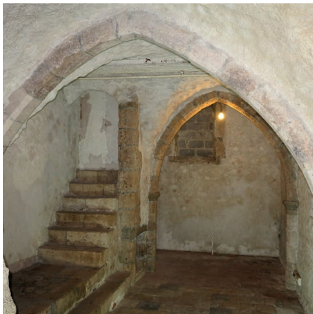
Fig 1 : Orléans (Loiret), caves du centre-ville, maison n° 43 rue de la Charpenterie : vue d'ensemble vers le nord de la cave à voûtes d'arêtes. (Clément Alix, pôle d'archéologie d'Orléans)
