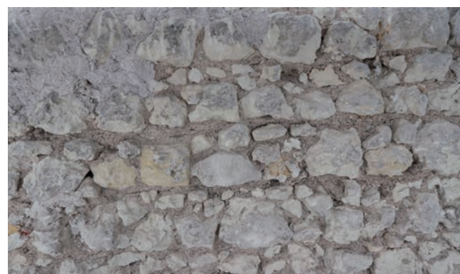
Fig 2 : Amboise (Indre-et-Loire) château royal : vue rapprochée de la maçonnerie la plus ancienne identifiée sur le rempart (US 1031) permettant d'observer la succession des journées de travail. (Nicolas Holzem, Inrap)
