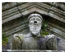
Détail portail ouest avant travaux
