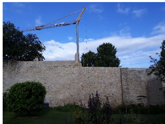
Rempart avant (gauche) et après (droite) restauration
