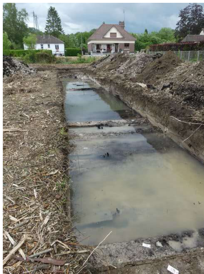
Aumale, rue Jeanne Leclerc, fig. 2 : vue générale de la tranchée sud depuis l'ouest ; on distingue l'alignement des pieux au centre de la tranchée et à gauche les poutres immergées. (S. Le Maho).
