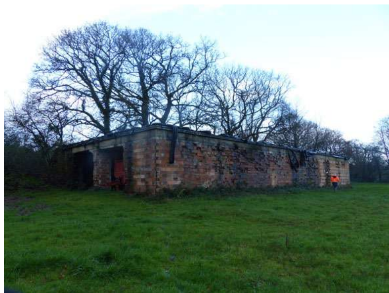
Fig. 3 : Yvetot-Bocage (50) : atelier de maintenance (type A) de missiles V1 (S. Lamache).
