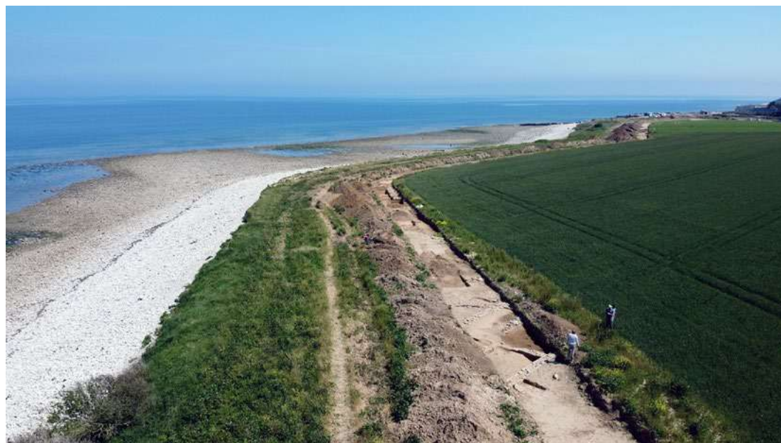
Grandcamp-Maisy, Le Pont du Hable : vue aérienne par drone de l'opération (CD 14).
