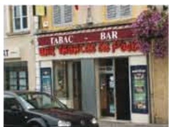
Contre-exemple de devanture en feuillure (la devanture n'est pas correctement mise en retrait par rapport au nu de la façade)
