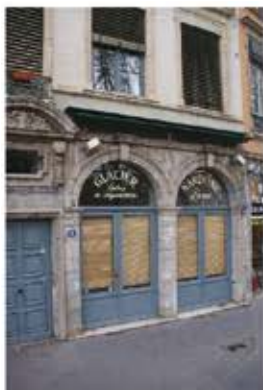
XVIIème siècle immeuble de l'époque médiévale
