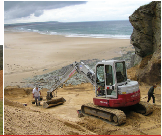
Travaux de terrassement, vue de la clôture, merlon de sable stocké sur le plateau destiné à reconstituer la dune et décapage à la mini-pelle des niveaux archéologiques. En bas, fouille fine sur treillis métallique.
