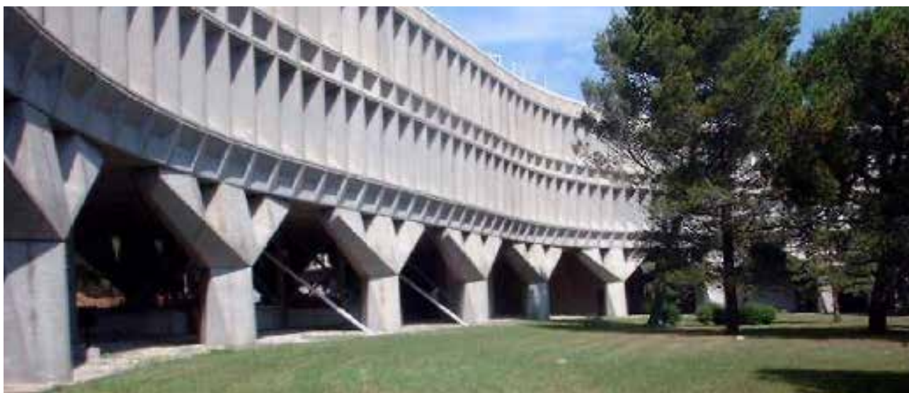
Projet de reconversion des anciens laboratoires IBM (architecture Marcel Breuer) à la Gaude en programme mixte logements/activités/résidences/loisirs piloté par Altea Cogedim, accompagné d'un parcours d'interprétation (Manifesto)
