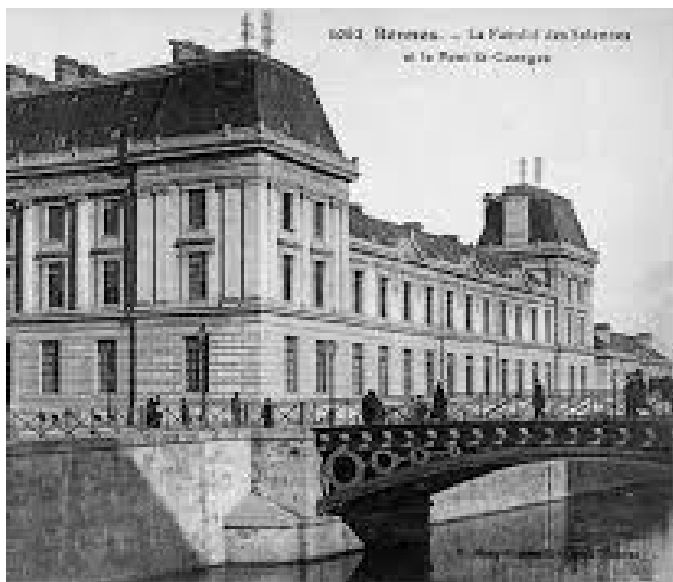
Hôtel Pasteur construit en 1888 - Rennes
