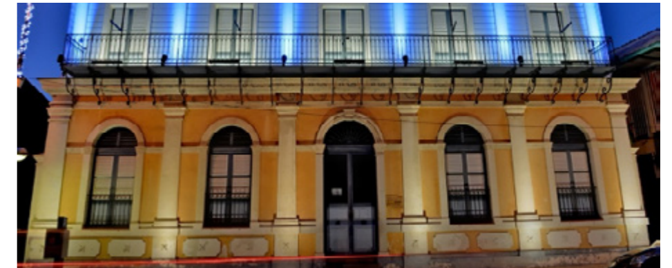
Médiathèque Achille René-Boisneuf © Ville de Pointe-à-Pitre
