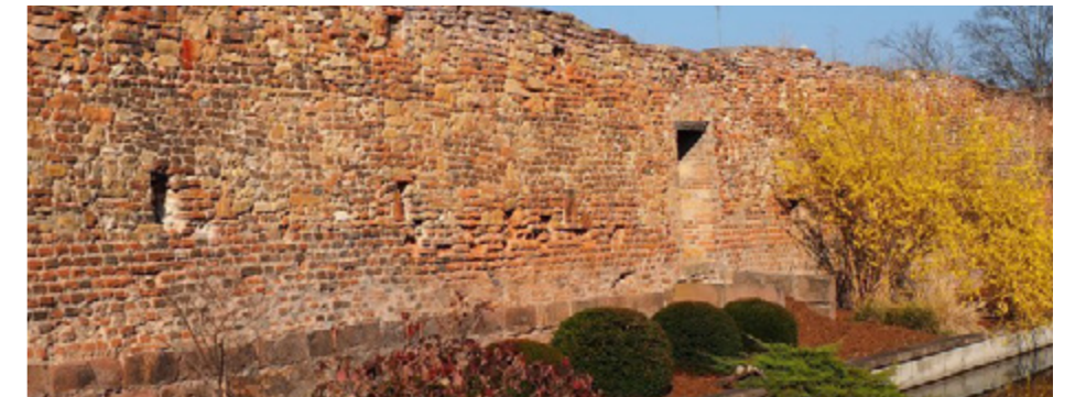
Fortifications médiévales de Colmar ©Martial Boutantin
