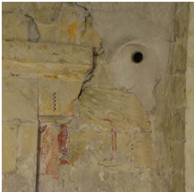
Montivilliers, Abbaye, fig. 1 : pot acoustique de la voûte gothique et décor peint (B. Bertholon).
