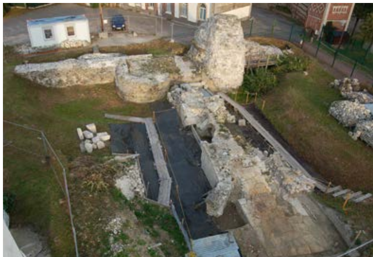
Harfleur, La Porte de Rouen : vue d'ensemble de la porte aux Cerfs, à l'arrière-plan, du pont dormant au centre et du dallage de la rampe d'accès, au 1 er plan (B. Duvernois).
