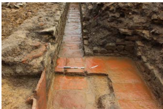
Portbail, Le Genestel : les deux états superposés de l'égout d'évacuation des salles chaudes des thermes (L. Paez-Rezende).
