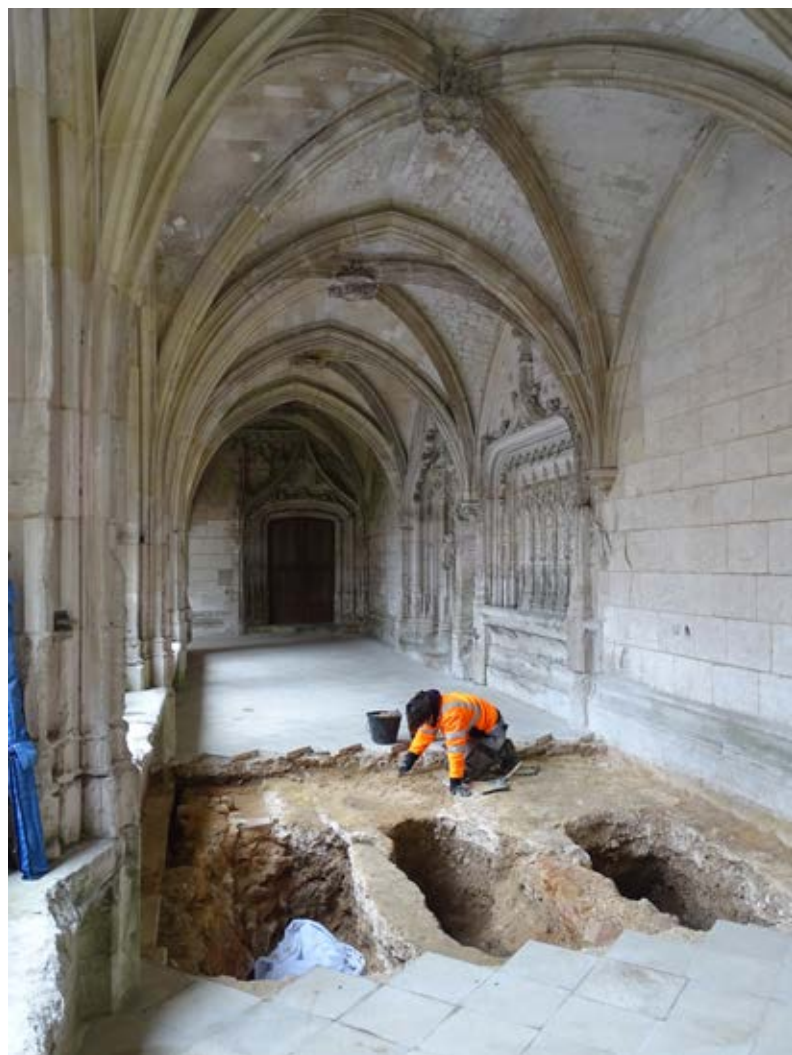
Rives-en-Seine, Abbaye Saint-Wandrille de Fontenelle, sondage archéologique dans l'une des travées de la galerie nord du cloître (G. Deshayes).
