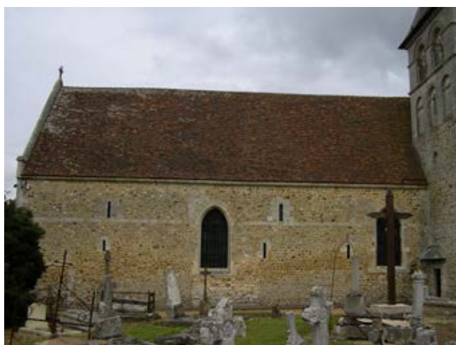
Nassandres-sur-Risle, église Saint-Martin de Fontaine-la-Soret : façade sud de la nef (N. Wasylszyn).
