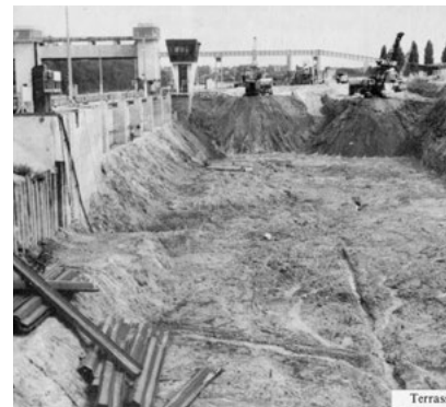
Chantier de l'écluse d'Andrésey © Club Historique d'Andrésey
