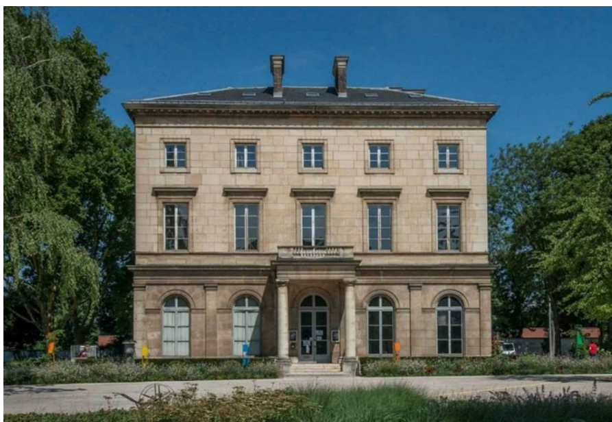
Crédit photo : DRAC Île-de-France – CRMH Château de Saint-Ouen-sur-Seine (Seine-Saint-Denis) Classement par arrêté du 9 mai 2019 https://www.pop.culture.gouv.fr/notice/merimee/PA00079960
