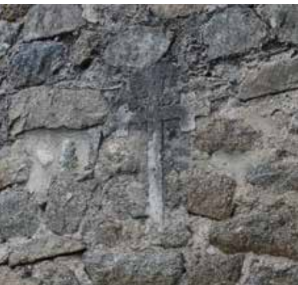
Sur l'abside de l'église, une signalisation de sépulture en enduit.
