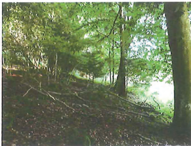
Fig. 93a et b. Vestiges de murets de soutènement des allées
