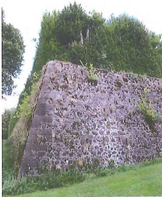
Fig. 70. Ce mur mérite d'être mis en valeur et nécessite un traitement soigné des abords.
