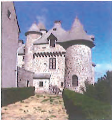
Fig. 77. La terrasse sud-est
