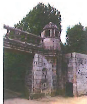
Fig. 22e Deux niches sous les échauguettes encadrent la porte
