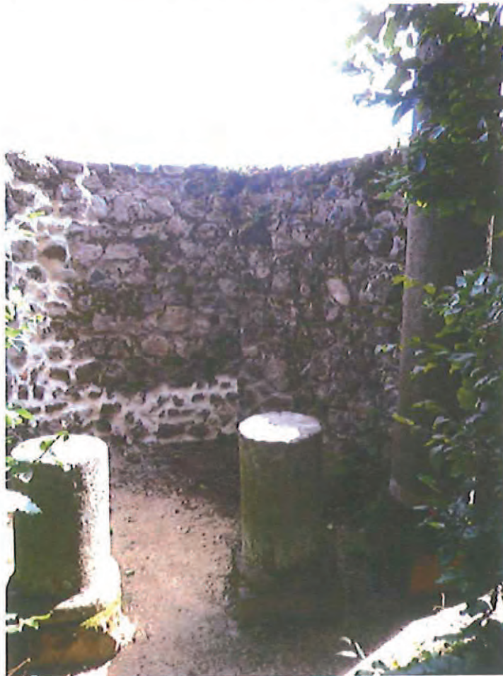
Fig. 51 : Vue des colonnes de Bonnevie : cet endroit est le point d'entrée du réseau hydraulique. Il devait comporter un point d'eau comme la vasque retrouvée à côté et les reprises du mur semblent l'indiquer.
