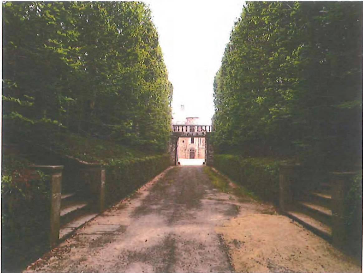
Fig. 20 Vue des escaliers latéraux de l'allée centrale
