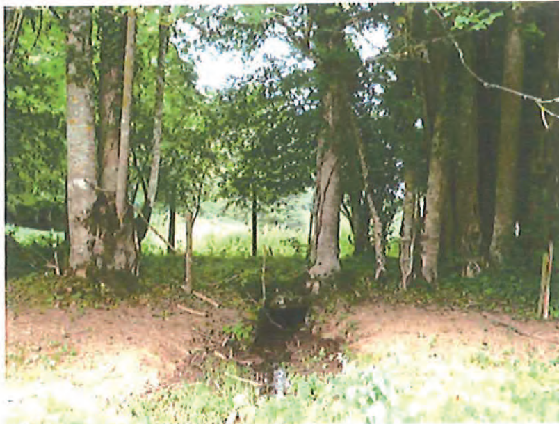
Fig. 97. La limite entre le pré de la Couleyre et le vallon de Cordès : un petit ouvrage hydraulique assure le passage du rû sous le chemin qui monte au château
