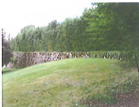
Fig. 67. Vue du mur depuis le sentier d'entrée
