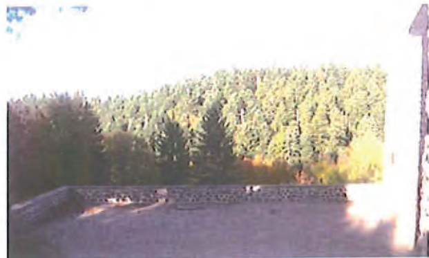
Fig. 78. La terrasse nord-ouest
