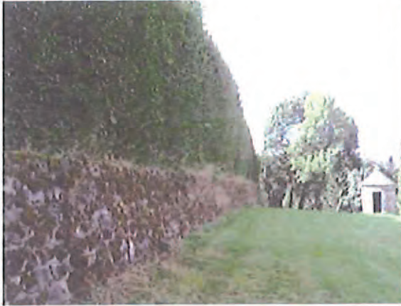
Fig.71. Le mur de soutènement et le bélier
