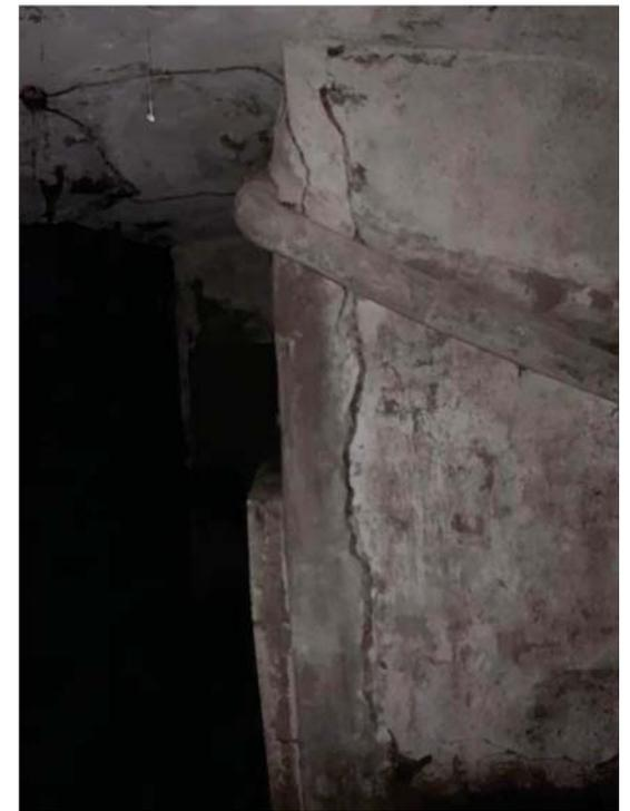
Fissuration du mur d'échiffre de l'escalier de cave du N°4
