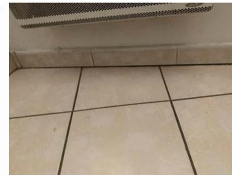
Affaissement d'un plancher d'étage au niveau du mitoyen
