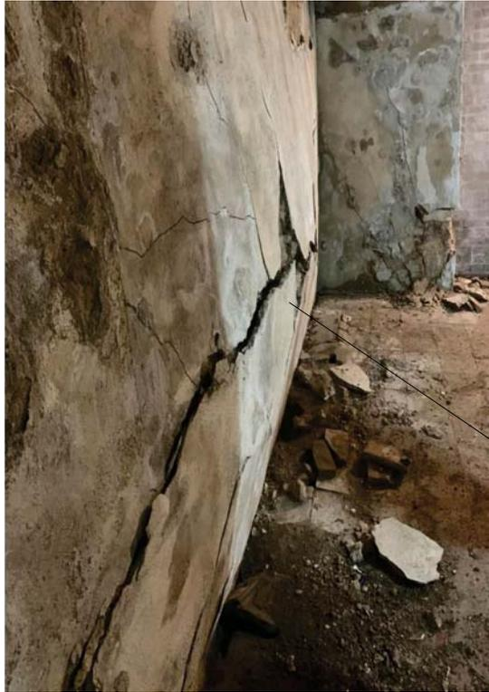
Bombement et Fissuration longitudinale du mur mitoyen
