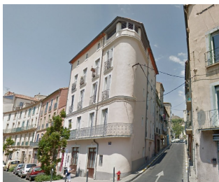
Surélévation en attique.
