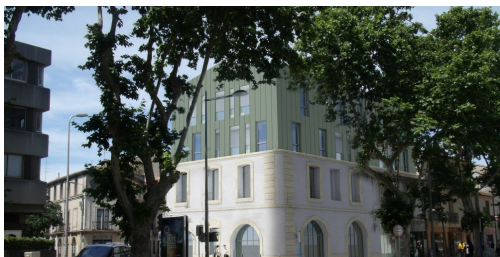
Surélévation en acier avec vêtire métallique.
