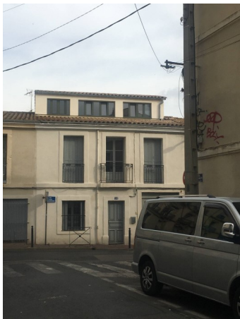
Surélévation partielle en toiture.
