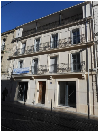
Surélévation en attique dans la continuité de l'existant.
