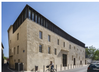
Surélévation en acier et conservation de toiture.
