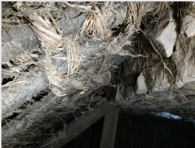
Ill. 55. Kerverec, Ploeren : détail de charpente. ©PNRGM. 2020
