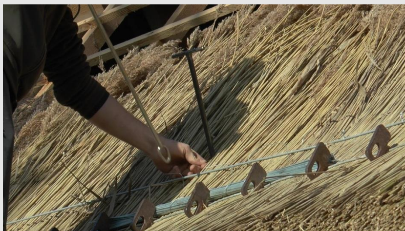
Ill. 32. Récupération du fil de ligature passé derrière le liteau par l'œillet de l'aiguille femelle. ©PNRGM. 2020
