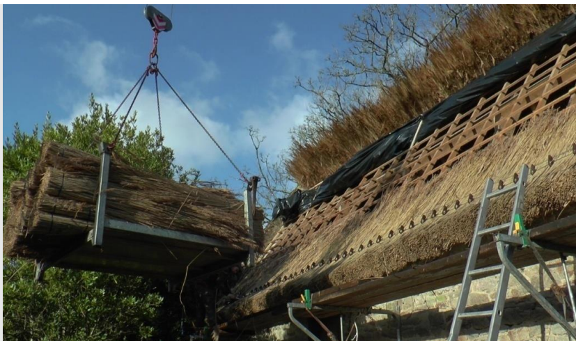
III. 21. Grue de levage et plateau de chargement. ©PNRGM. 2020
