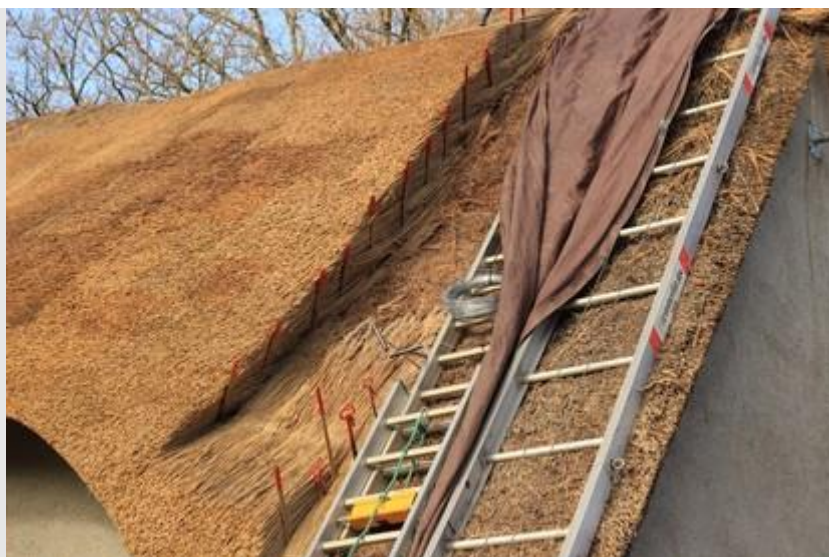
Ill. 19. Maintien du chaume déjà posé par des piquets d'arrêt ©PNRB. 2021
