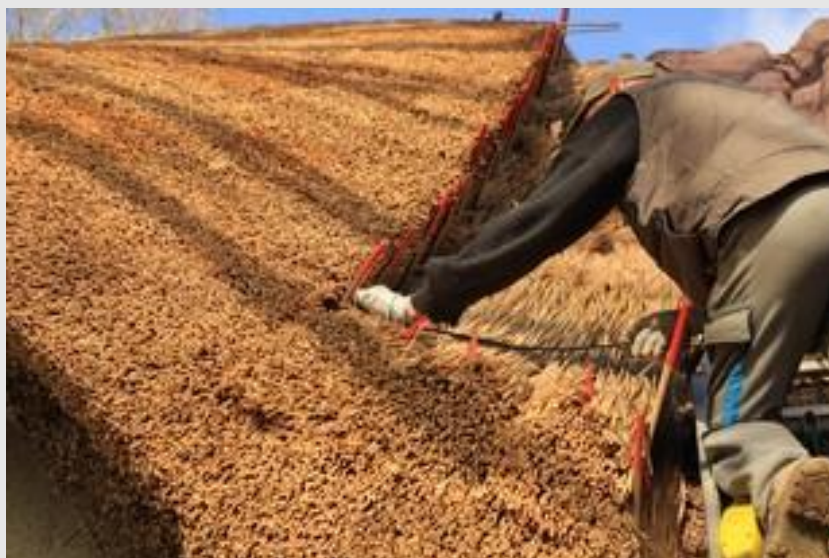
Ill. 17. Installation d'une barre métallique ©PNRB. 2021
