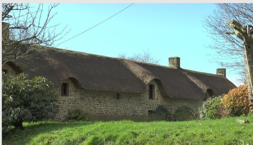
Ill. 37. Cahire, Plougoumelen (site classé) : faîtage en ciment. ©PNRGM. 2020
