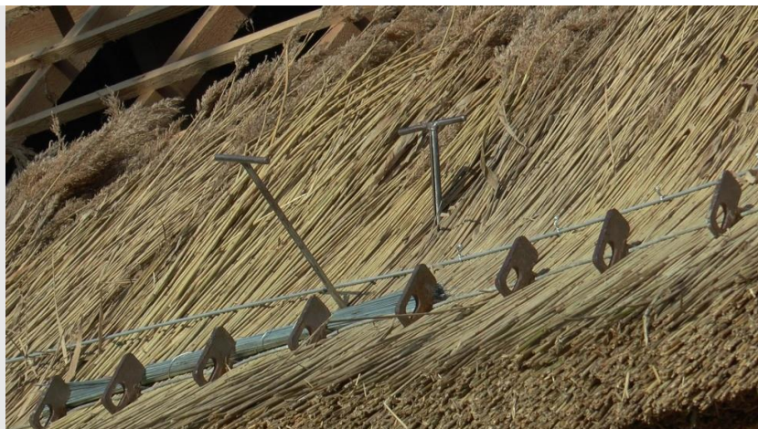
III. 23. Détail d'une couverture. De haut en bas : aiguilles ; barre de fixation définitive et fils de ligature vrillés ; crémaillères et barre de travail. ©PNRGM. 2020
