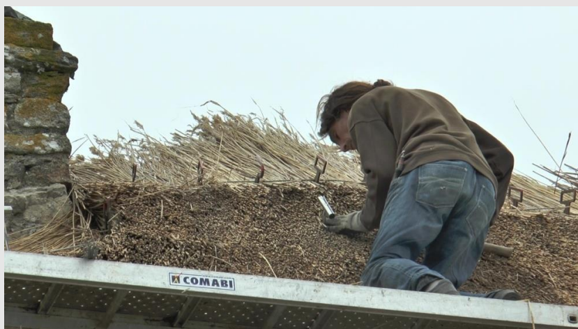
Ill. 14. Contrôle de l'épaisseur du chaume à l'aide d'une aiguille graduée. ©PNRGM. 2020
