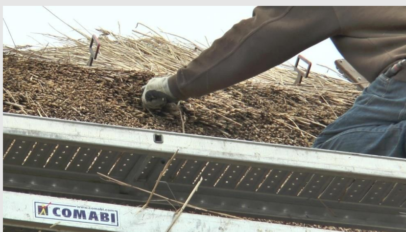
III. 28. Tirage du roseau pour le remettre en forme avec la palette. ©PNRGM, 2020
