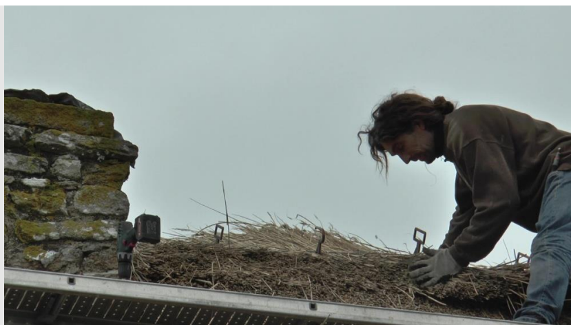
III. 26. Cassage des bottes et premier façonnage à la main pour mettre le roseau dans la pente. ©PNRGM, 2020
