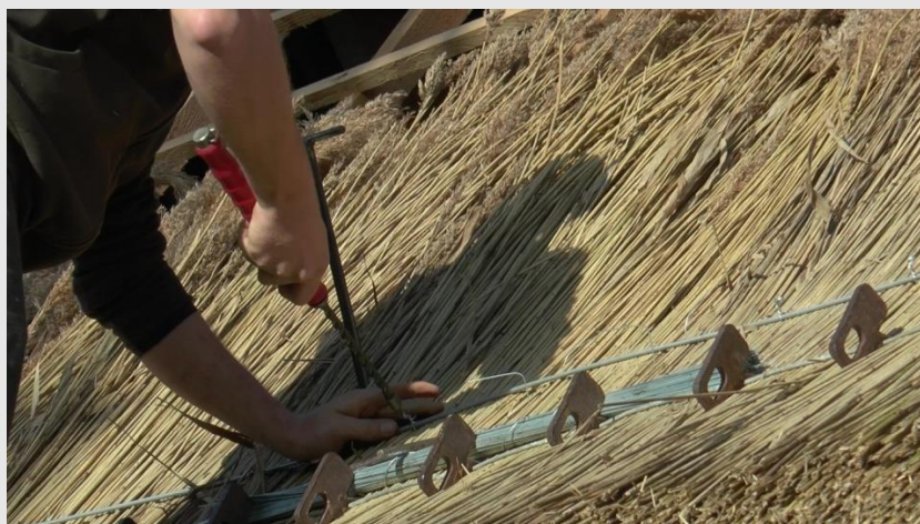
Ill. 33. Fixation des fils de ligature à l'aide d'un « tourniquet ». ©PNRGM. 2020
