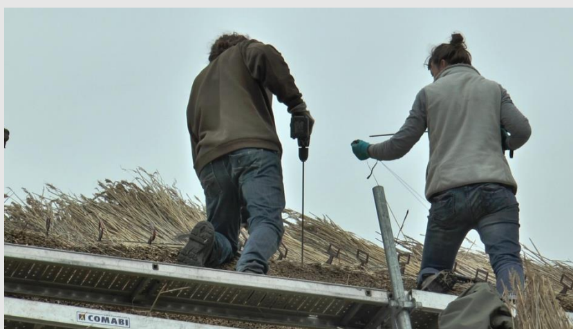
III. 30. Fils de ligature vissés sur les liteaux au niveau du faîtage. ©PNRGM. 2020
