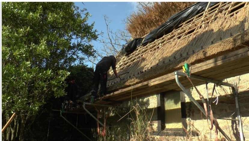
Ill. 34. Serrage de la barre de fixation à l'aide d'un levier. ©PNRGM. 2020
