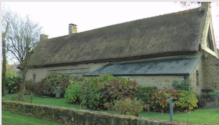
III. 53. Bodéno, Plougoumelen : échelle resserrée contre le mur arrière. ©PNRGM. 2020
