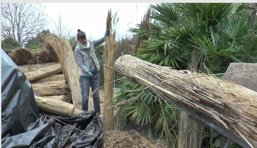
Ill. 10. Bottes de roseau prêtes à être posées en couverture. ©PNRGM. 2020
