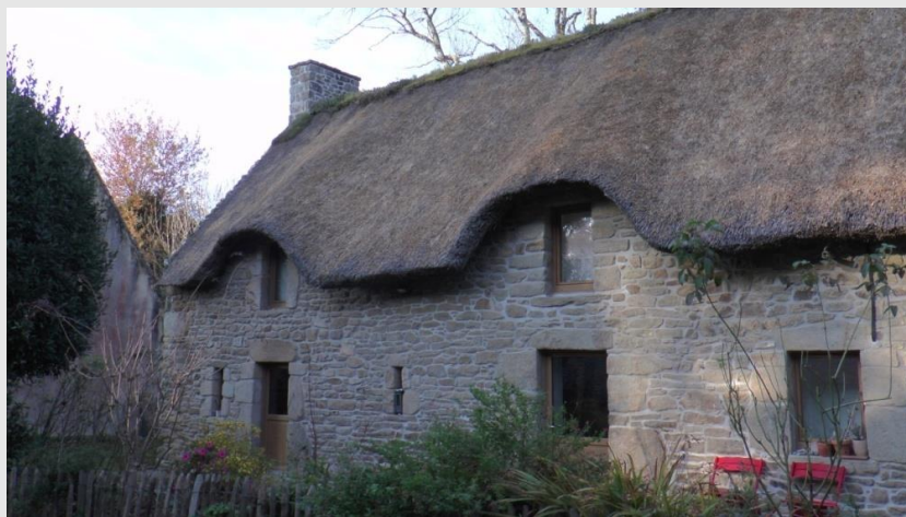
Ill. 36. Lestréviau, Plougoumelen : faîtage en terre. ©PNRGM. 2020
