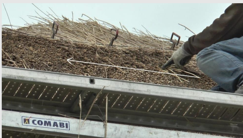
III. 27. Ligne de démarcation entre deux rangs de roseau (flèche blanche). ©PNRGM, 2020
