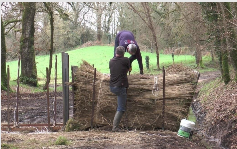
III. 5. Serrage et ligature du ballot. ©PNRGM. 2020
