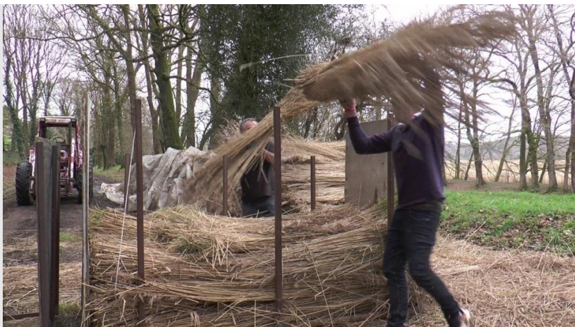
III. 4. Disposition des gerbes de roseau en quinconce dans la matrice rectangulaire. ©PNRGM. 2020
