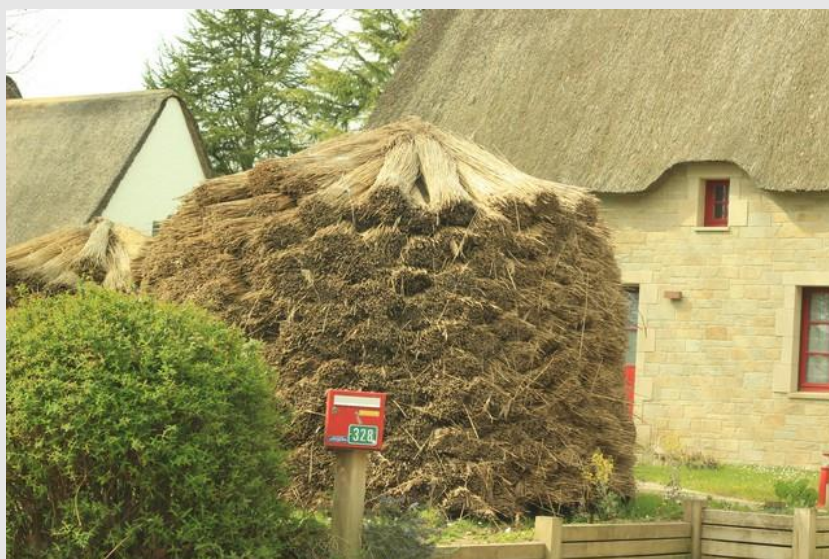
III. 8. Stockage en tourelle en attendant la pose en couverture. ©PNRB. 2021
