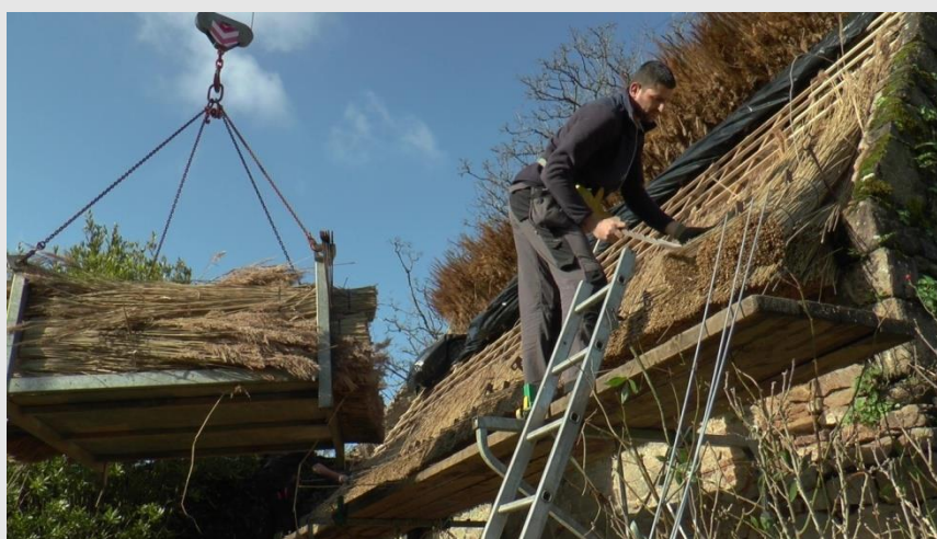
III. 24. Pose d'une botte. Dans la main du couvreur, la crémaillère qui la maintiendra en place. ©PNRGM. 2020
