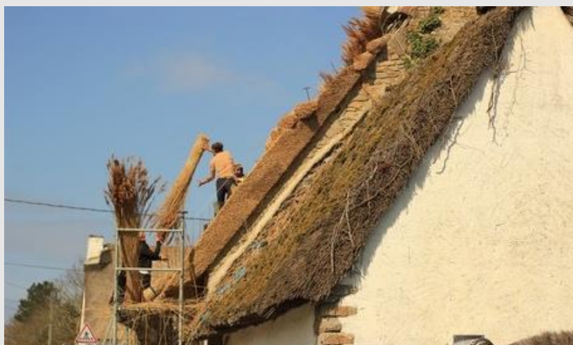
Ill. 20. Bottes hissées manuellement ©PNRB. 2021
