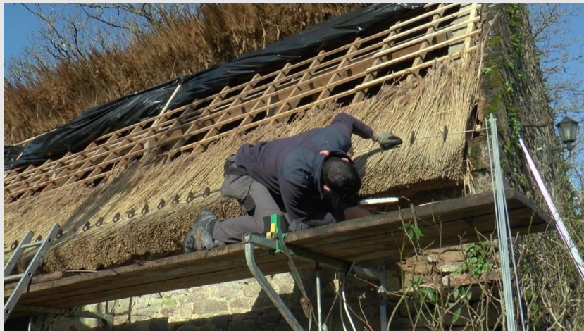
Ill. 13. Façonnage du larmier à l'aide d'une palette. ©PNRGM. 2020
