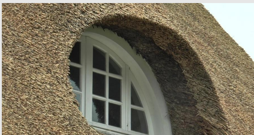
III. 11. Détail d'une lucarne : le chaume neuf, plus clair, se démarque nettement du chaume ancien, plus foncé. ©PNRGM. 2020
