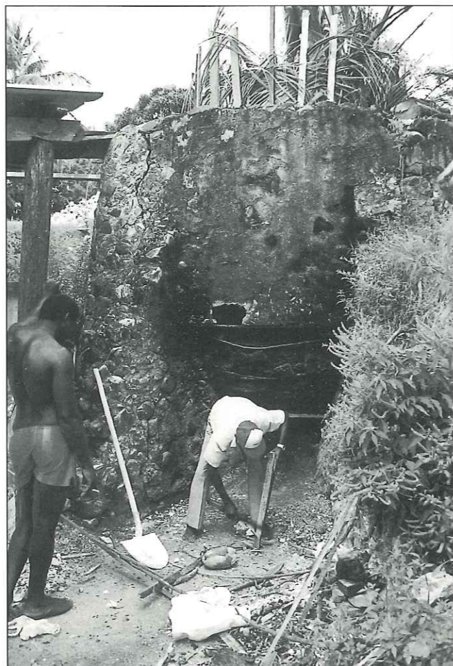
fig. 6 Le Lamentin, four à chaux. Cliché M. Guillaume.
