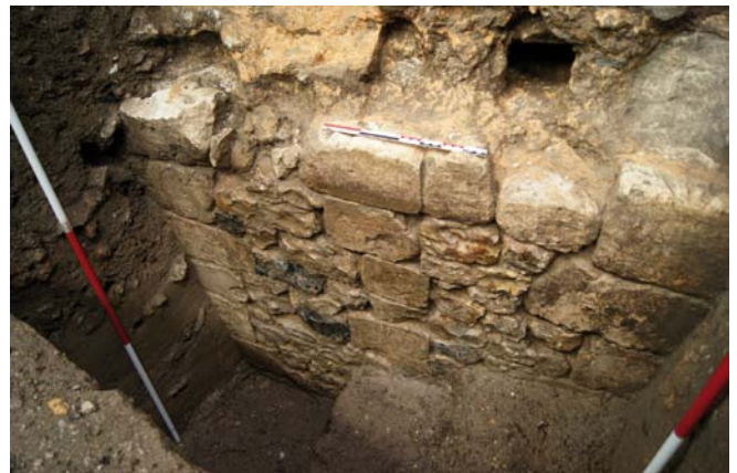
Pont-Audemer, Rue de la Seule : parement d'un mur massif composé de plusieurs pierres de taille en remploi (G. Deshayes)
