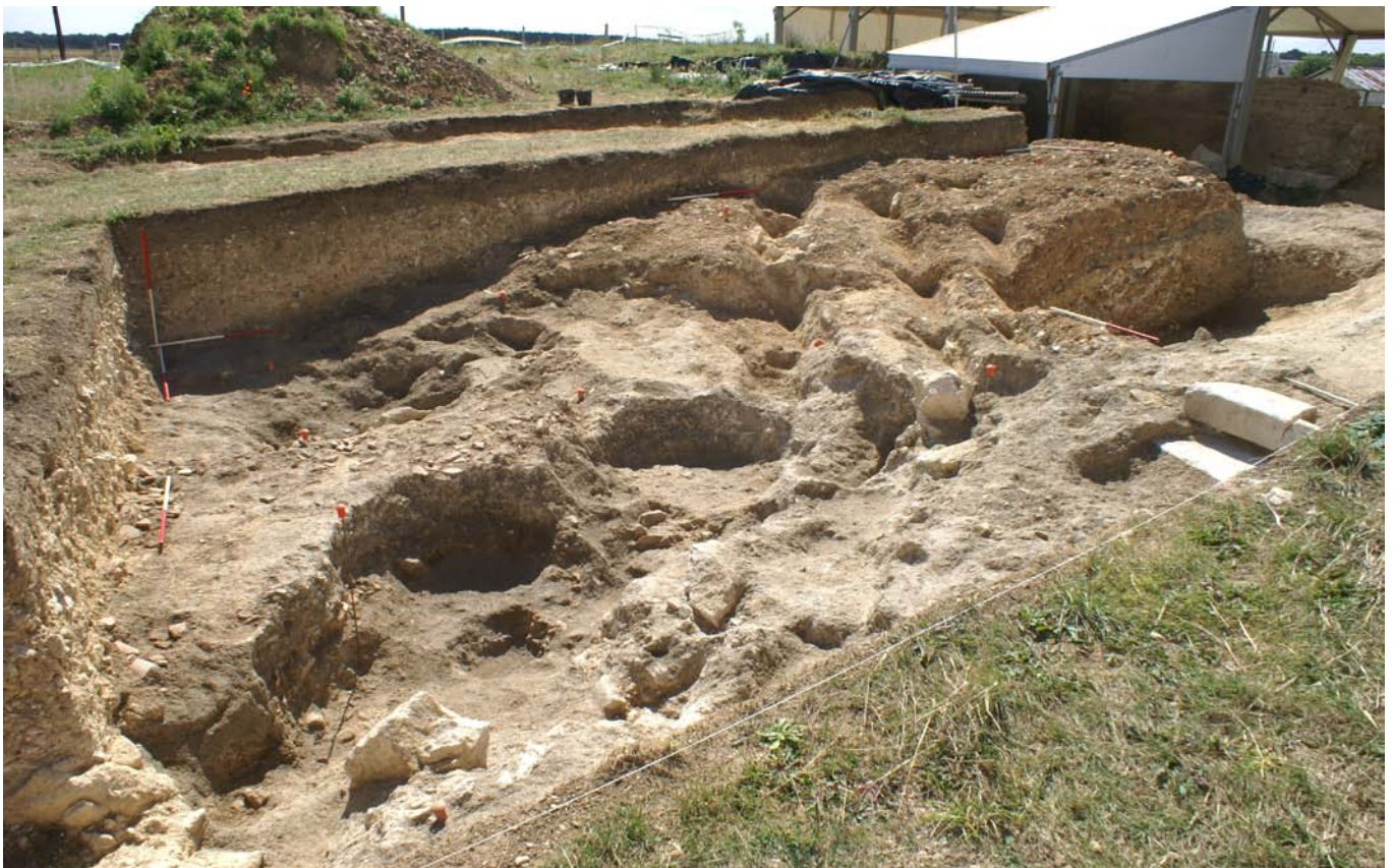
Le Vieil-Évreux, Le Grand Sanctuaire : vue du chantier de démolition (MADE)
