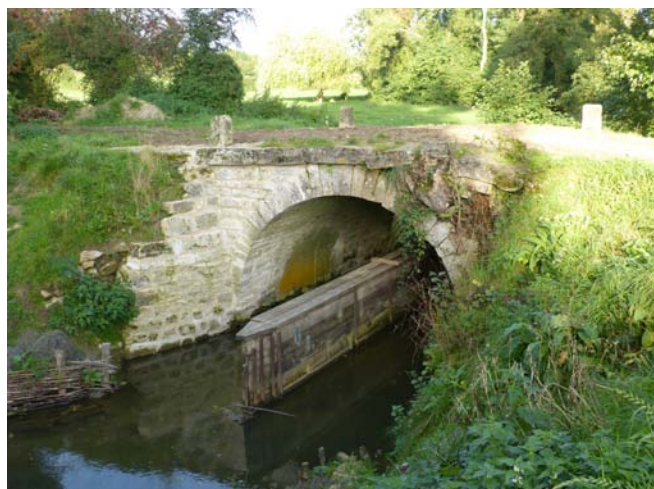
Ménerval et Saumont-la-Poterie, Le Pont de Coq, fig. 1 : vue du pont depuis l'amont (P.-F. Thérain)
