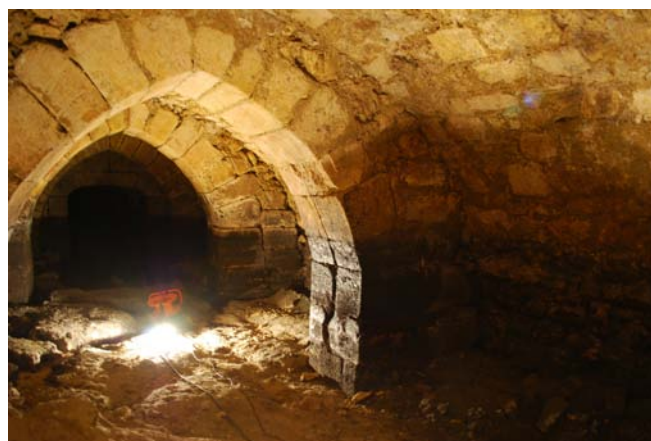
Gaillon, Château : au fond de l'ancien fossé du château : une galerie dont la voûte est confortée par de puissants doubleaux (D. Pitte)
