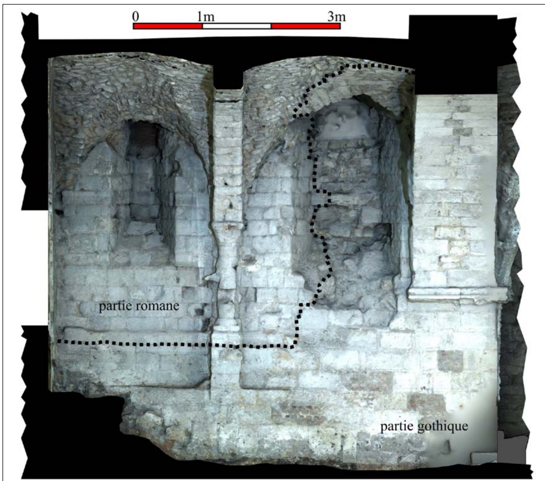
Rouen, Archevêché, fig. 5 : relevé photogrammétrique de deux travées du mur est de la salle (É. Follain)
