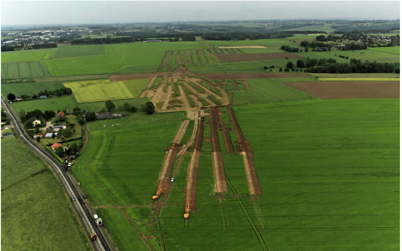
Mesnil-Panneville, A150, section 2 tranche 1G : réalisation des tranchées par les équipes de pelle D et E. Au premier plan, Bouville en bordure de la RD 104, à l'arrière-plan Villers-Écalles (J. Refuveille)
