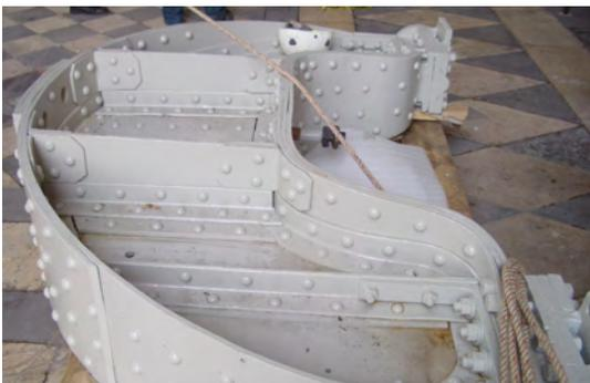
La puissante charpente d'acier riveté qui porte le plancher du beffroi est un ouvrage remarquable et caractéristique de l'architecture industrielle de la fin du XIX<sup>e</sup> siècle. Les extrémités des longrines, dépassant au dehors des baies, étaient vulnérables et feuilletées par la corrosion. Elles ont été raccourcies et protégées. La structure métallique a été restaurée et soulagée sur ses appuis par des consoles de pierre dotées de platines en néoprène.
