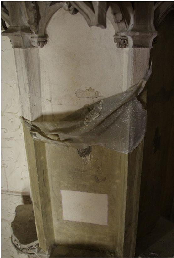
Après un dépoussiérage au pinceau et à l'aspirateur, un nettoyage avec une pâte filmogène (latex) est appliqué pour désincruster les salissures. Les parties très ouvragées sont nettoyées au coton tige et à l'eau déminéralisée.
