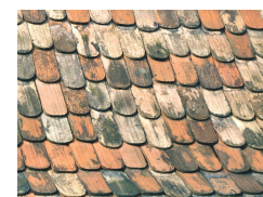
Couverture à simple recouvrement
