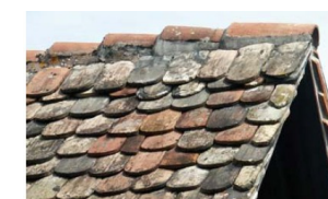
Couverture à double recouvrement
