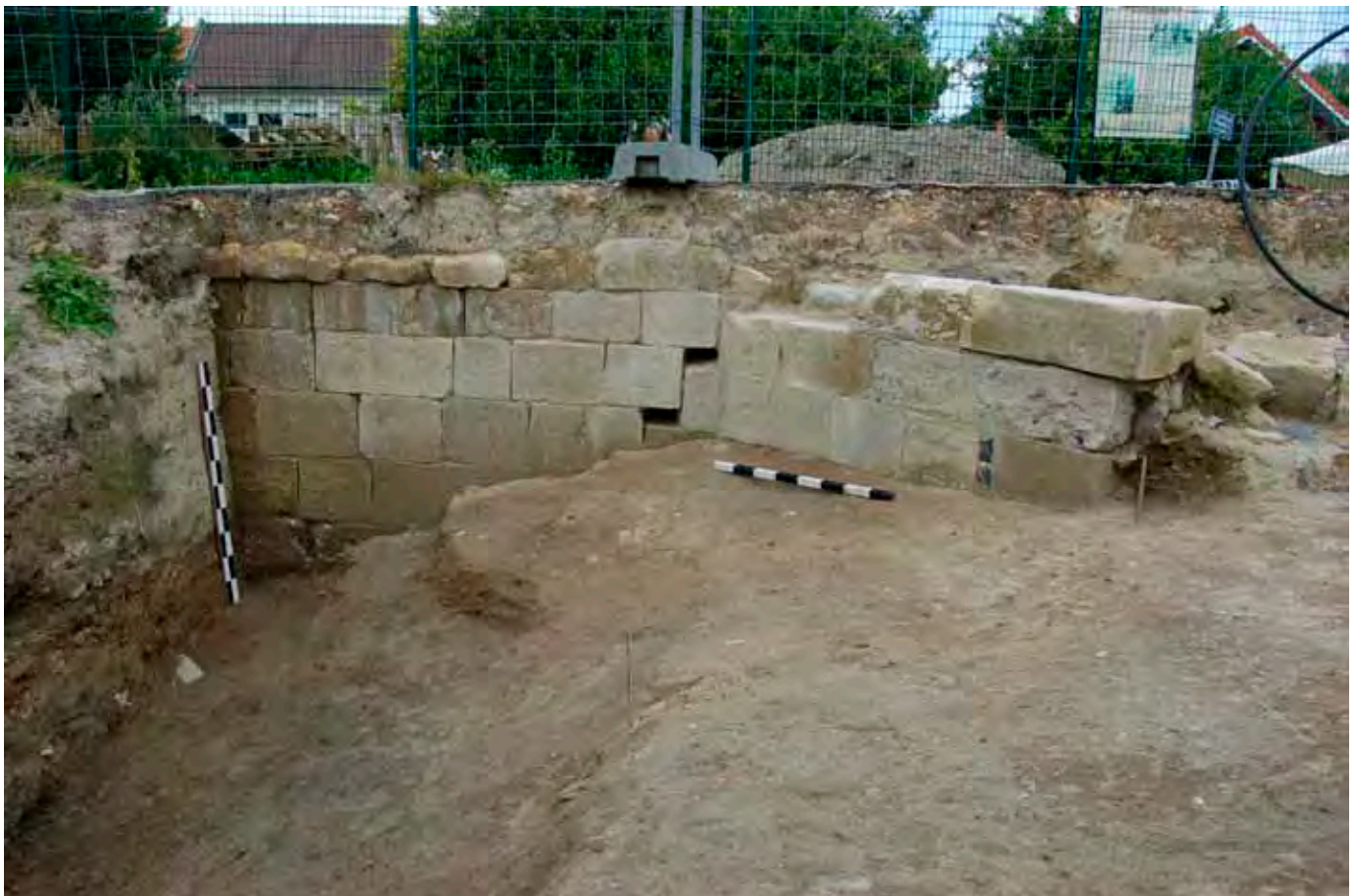
Harfleur, Porte de Rouen : Pont dormant, parement sud. A droite, muret de réception de la chaussée s'affaissant (B. Duvernois)
