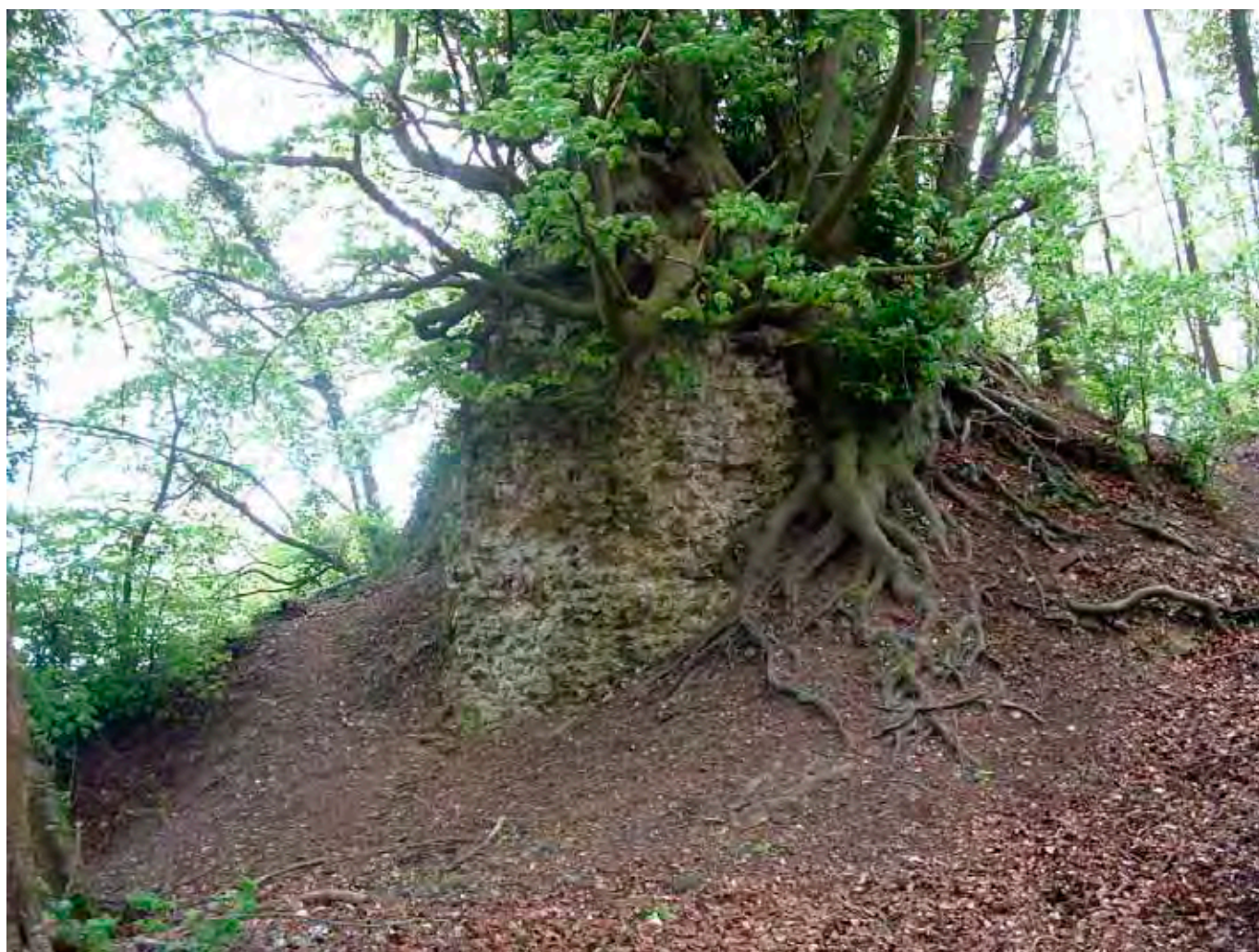
Orival, La Roche Fouet : Maçonneries médiévales du château de la Roche Fouet en forêt domaniale de La Londe-Rouvray (T. Lepert)
