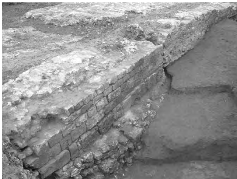
Louviers, Place de la Demi-Lune : Fondations de la tour polygonale, face sud-est (É. Mare)
