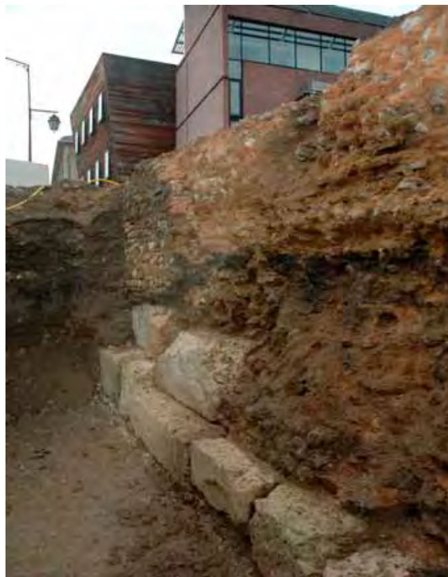
Évreux, Théâtre municipal : Vue du parement externe du rempart. Le collage de la réfection moderne sur le blocage antique s'est détaché au premier plan à droite de la photographie. (É. Follain)
