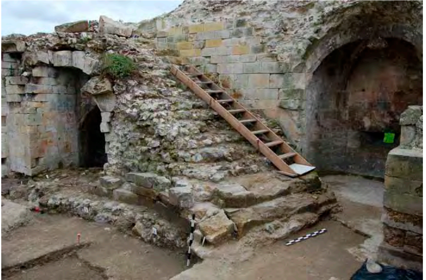
Harfleur, Porte de Rouen : Escalier monumental sur une imposante fondation. A gauche, partie montante accessible directement depuis la chaussée. A droite, partie descendante protégée par le mur frontal (B. Duvernois)
