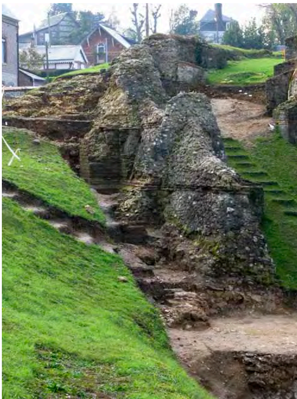
Lillebonne, le théâtre : Zone extérieure du mur périmétral : mur M17
