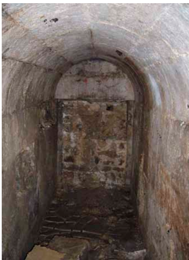
Rouen, 3 place Saint-Hilaire : Fond du passage, condamné par un mur (P. Moitrel)
