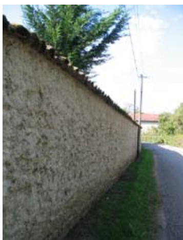
Mur en pisé enduit à la chaux
