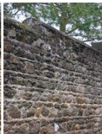
Mur en moellons de pierres assisées
