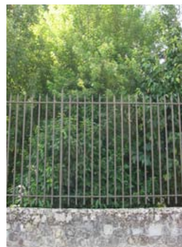
Mur bahut soutenant une clôture en ferronnerie
