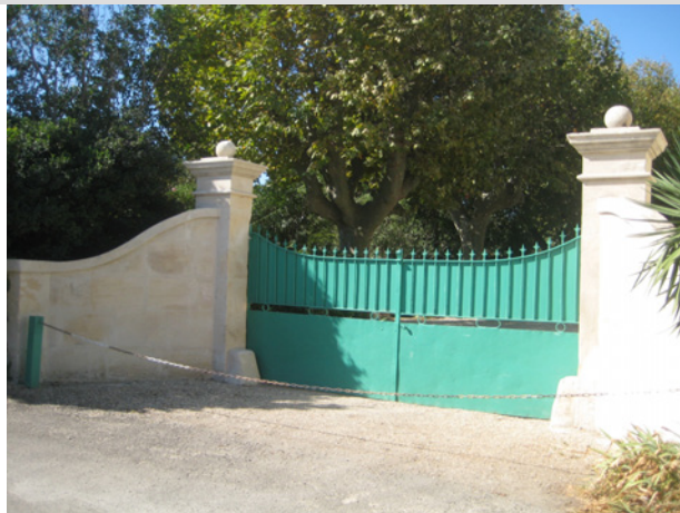
Portail d'entrée de la cour (cl. EMJ, 2008).
