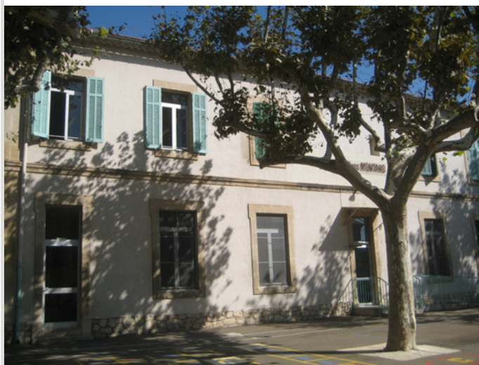
Façade sur la cour (cl. EMJ, 2008).
