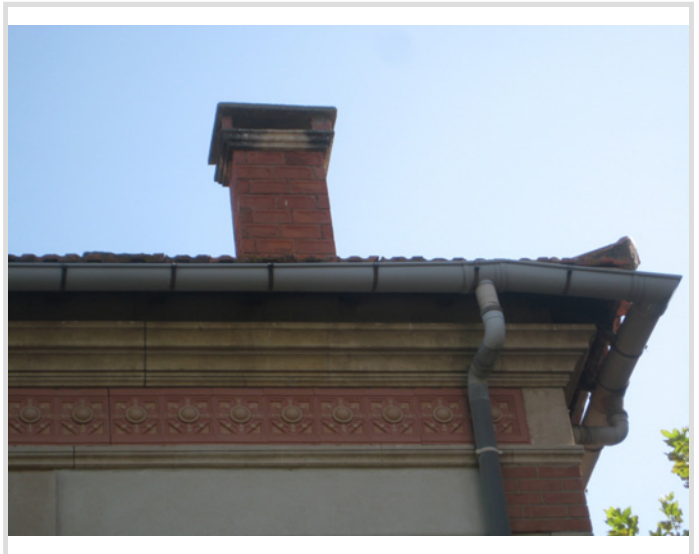
Détail de la façade sur la rue (cl. EMJ, 2008).
