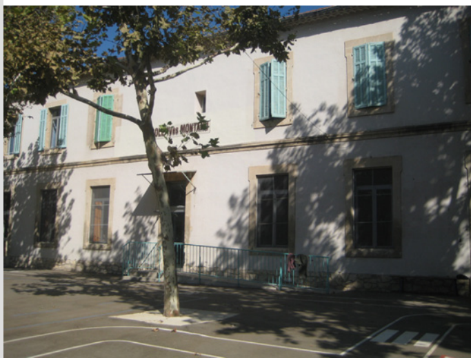
Façade sur la cour (cl. EMJ, 2008).
