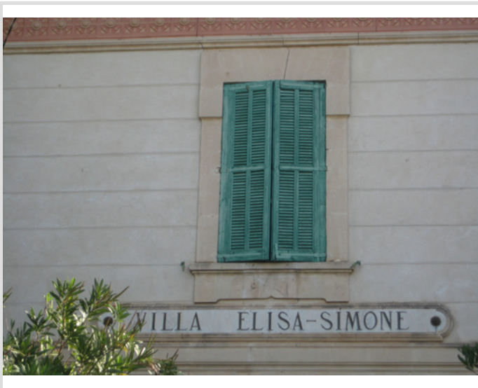
Détail de la façade sur la rue (cl. EMJ, 2008).
